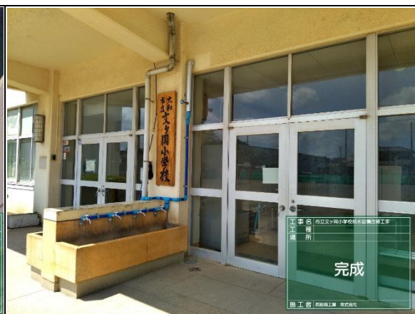
② 完成（屋外手洗い場）
