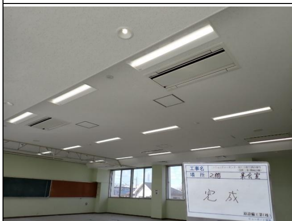
③ 完成（空調室内機）
