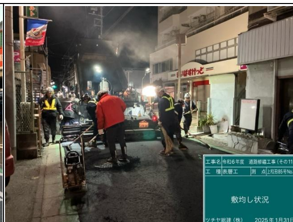
② 施工状況（舗装敷き均し）
