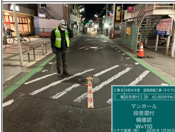
③ 施工状況（段差擦付）
