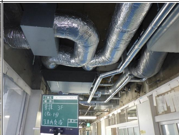
④ 完成（天井内・機器、ダクト等）
