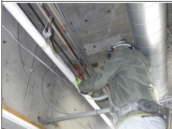
③ 施工状況
