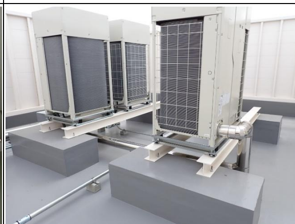
④ 完成（屋上・空調室外機）
