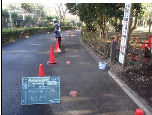
① 仮設状況
