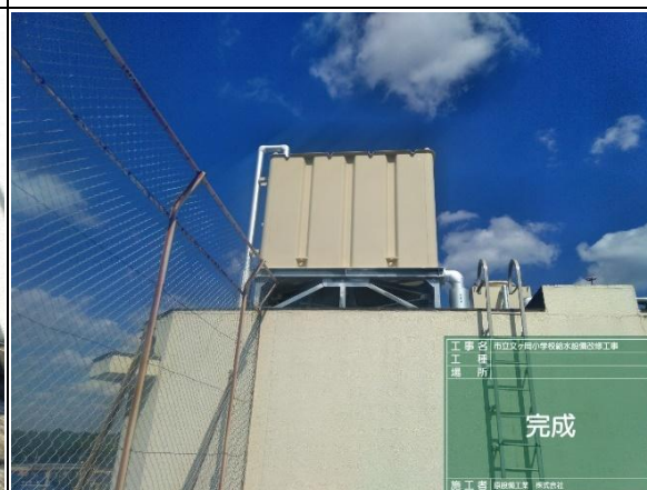
④ 完成（高架水槽）
