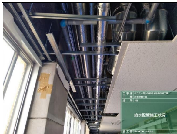
① 施工状況（廊下天井内給水管）
