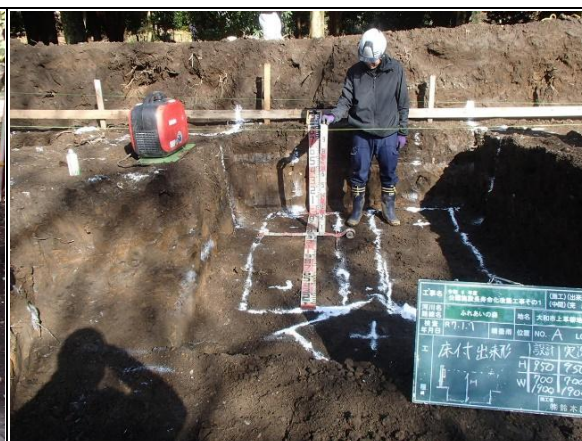
② 施工状況（基礎掘削）
