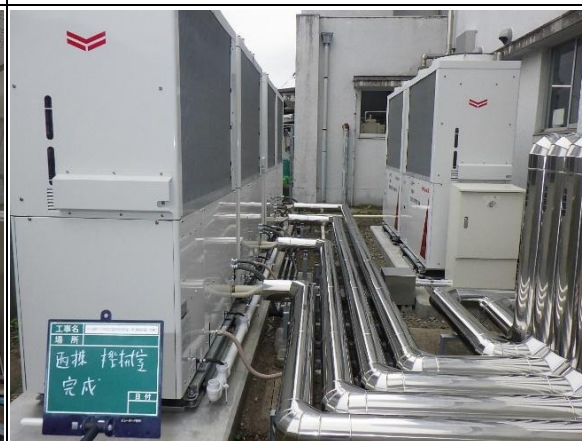
④ 完成（室外機）
