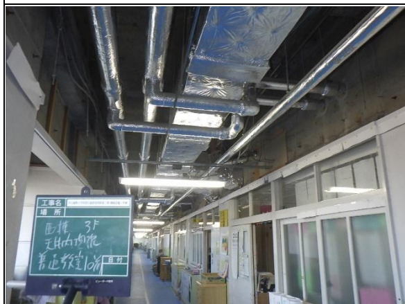
① 着手前（廊下天井内・既設ダクト等）
