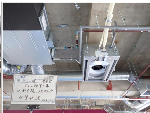
② 施工状況（天井内・機器、配管）
