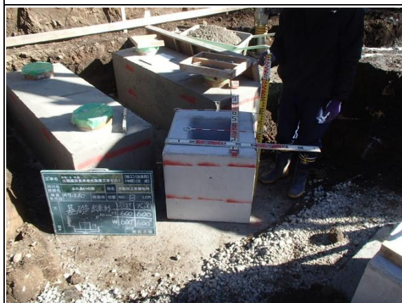
③ 施工状況（基礎設置）
