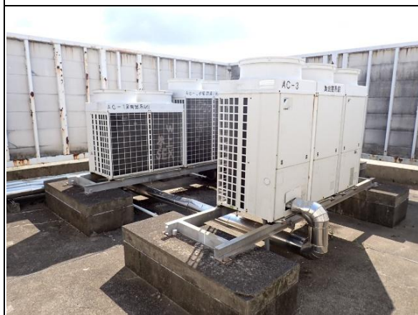
① 着手前（屋上・空調室外機）
