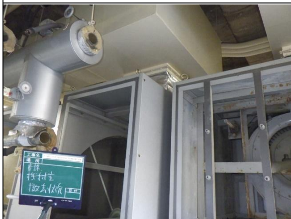
① 撤去状況（エアハンドリングユニット）
