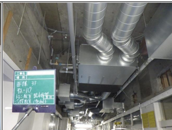
② 施工状況（廊下天井内・全熱交換器）
