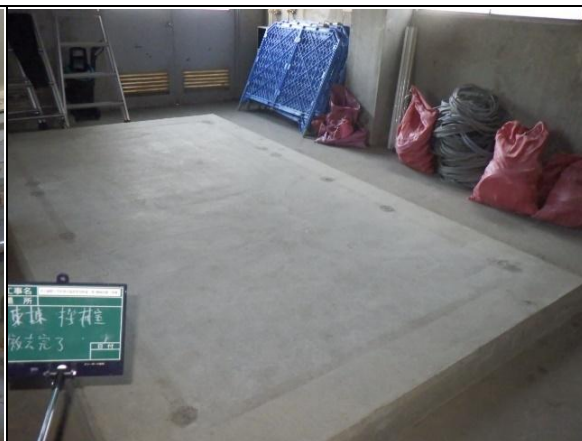
② 撤去完了
