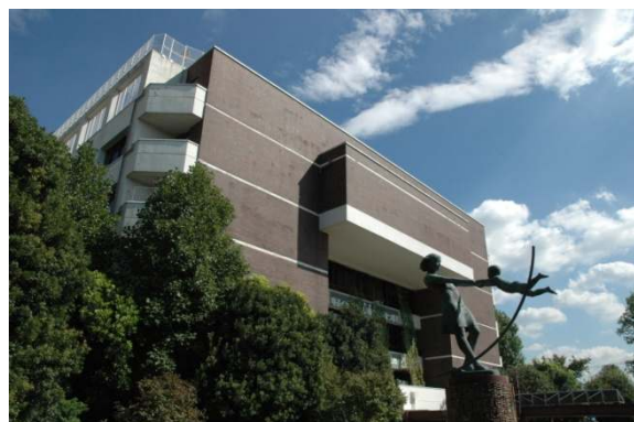
大和市役所 本庁舎 (昭和 49 年 3 月 1 日竣工)
