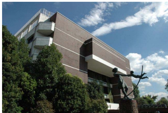
大和市役所 本庁舎 (昭和 49 年 3 月 1 日竣工)
