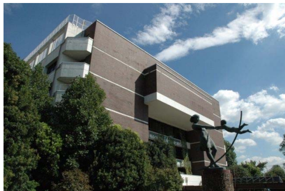
大和市役所 本庁舎 (昭和 49 年 3 月 1 日竣工)
