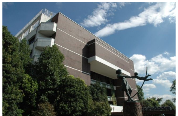
大和市役所 本庁舎 (昭和 49 年 3 月 1 日竣工)
