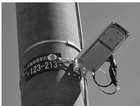
防犯灯管理プレート(6桁の管理番号)
