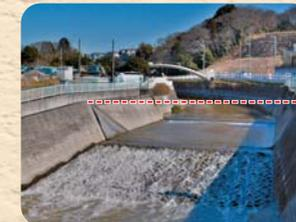
大和市南端から約5.5km(河口から9km弱)の藤沢市円行にある石川堰。写真は堰が上がっていない状態で、使用時には堰の上端が破線の位置(高さ3.3m)になる。
