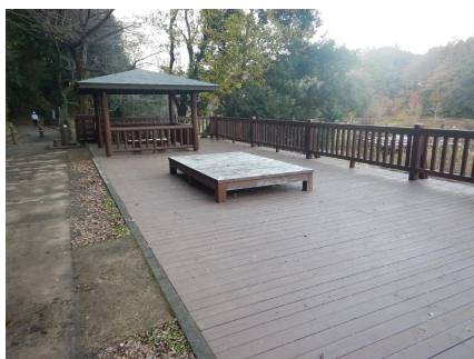
木製施設改修工事 (泉の森)
