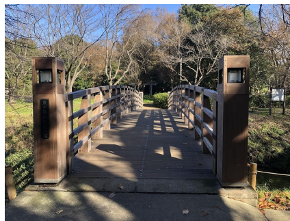
木製施設改修工事 (ふれあいの森)
