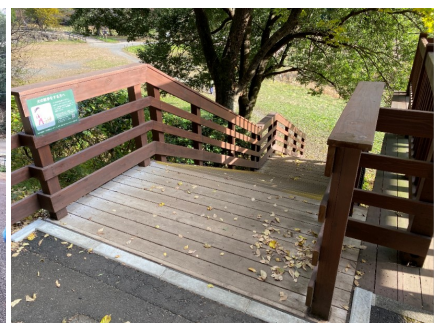
木製施設改修工事 (泉の森)
