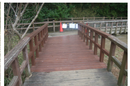
木製施設改修工事 (泉の森)
