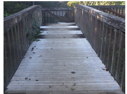
木製施設改修工事 （泉の森）
