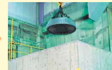
●鉄搬出用クレーン
