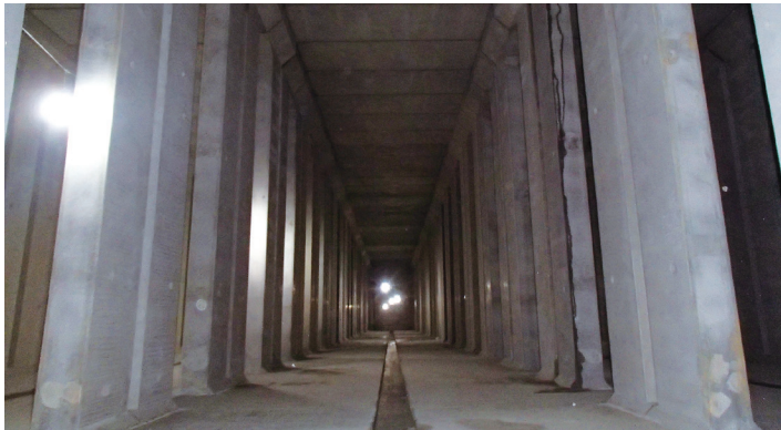
同調整池内部の深さは約6メートル
