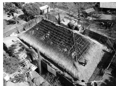
上空から見たふき替え作業
