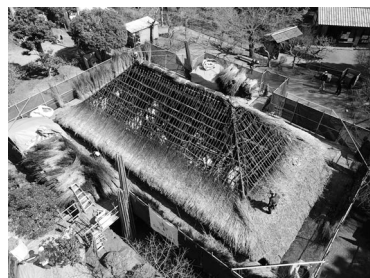
上空から見たふき替え作業
