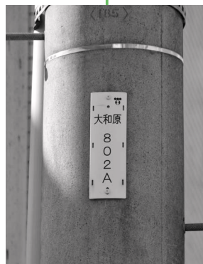
電柱の管理番号で 通報場所が分かります
