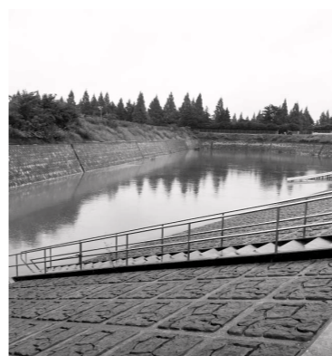
環境補足協定に基づく立入調査時の基地内調整池(綾瀬市域)の様子
