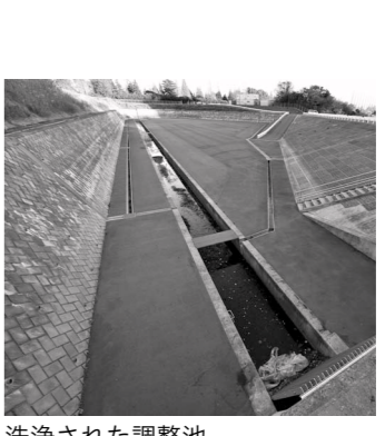
洗浄された調整池
