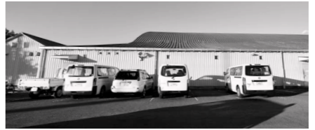
泡消火剤放出のあった格納庫
