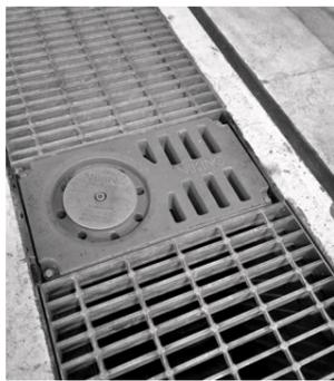
格納庫床面の泡消火剤放出口。泡消火設備が作動すると泡消火剤が斜め上方へ放出される
