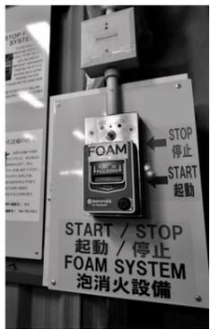
誤作動が起きた泡消火設備の制御盤
