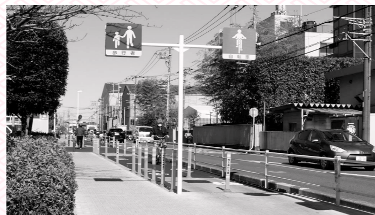
大和オークシティの東側に整備した自転車通行空間
