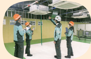
揺れ止め施工の有無で、地震による空調設備の揺れがどう違うか比較
