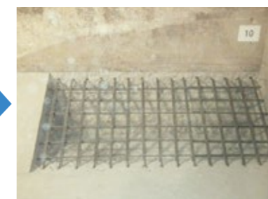
新たに鉄筋を設置します。
