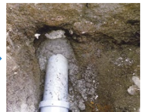
下水管を新しい管に交換した様子
