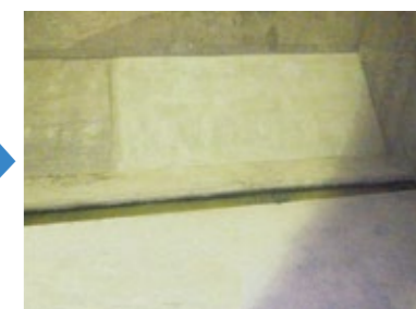
コンクリートを打ち込み、固まれば完成です。
