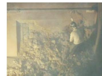
耐震強度不足の壁を取壊し、新しい壁に造り替えます。
