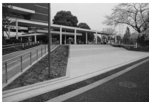
拡幅し、スロープも整備した市役所西側の通路
