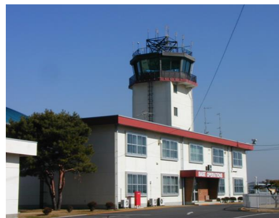
現在の厚木基地の管制塔
