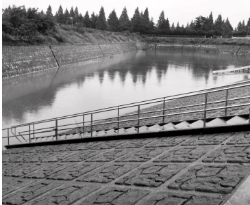
環境補足協定に基づく立入調査時の基地内調整池(綾瀬市域)の様子
