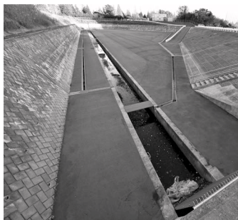
洗浄された調整池
