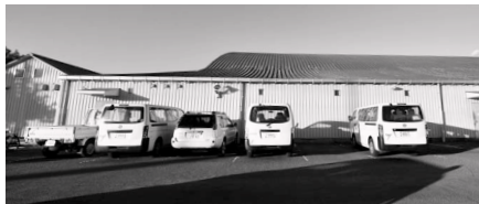
泡消火剤放出のあった格納庫
