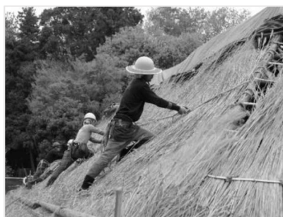
※郷土民家園（旧小川家）茅葺屋根葺き替え
