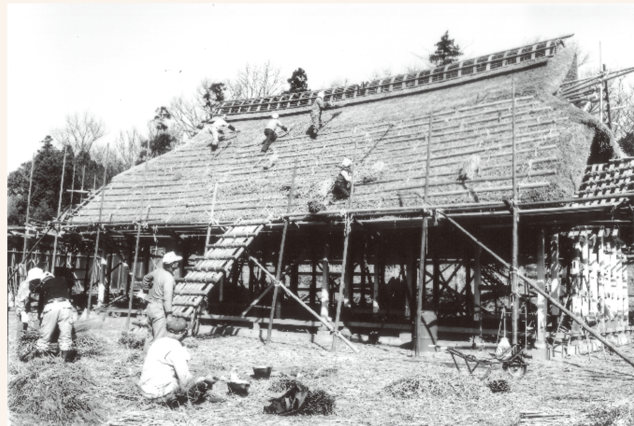
大和市郷土民家園での屋根葺き（平成5（1993）年 | 上草柳）
