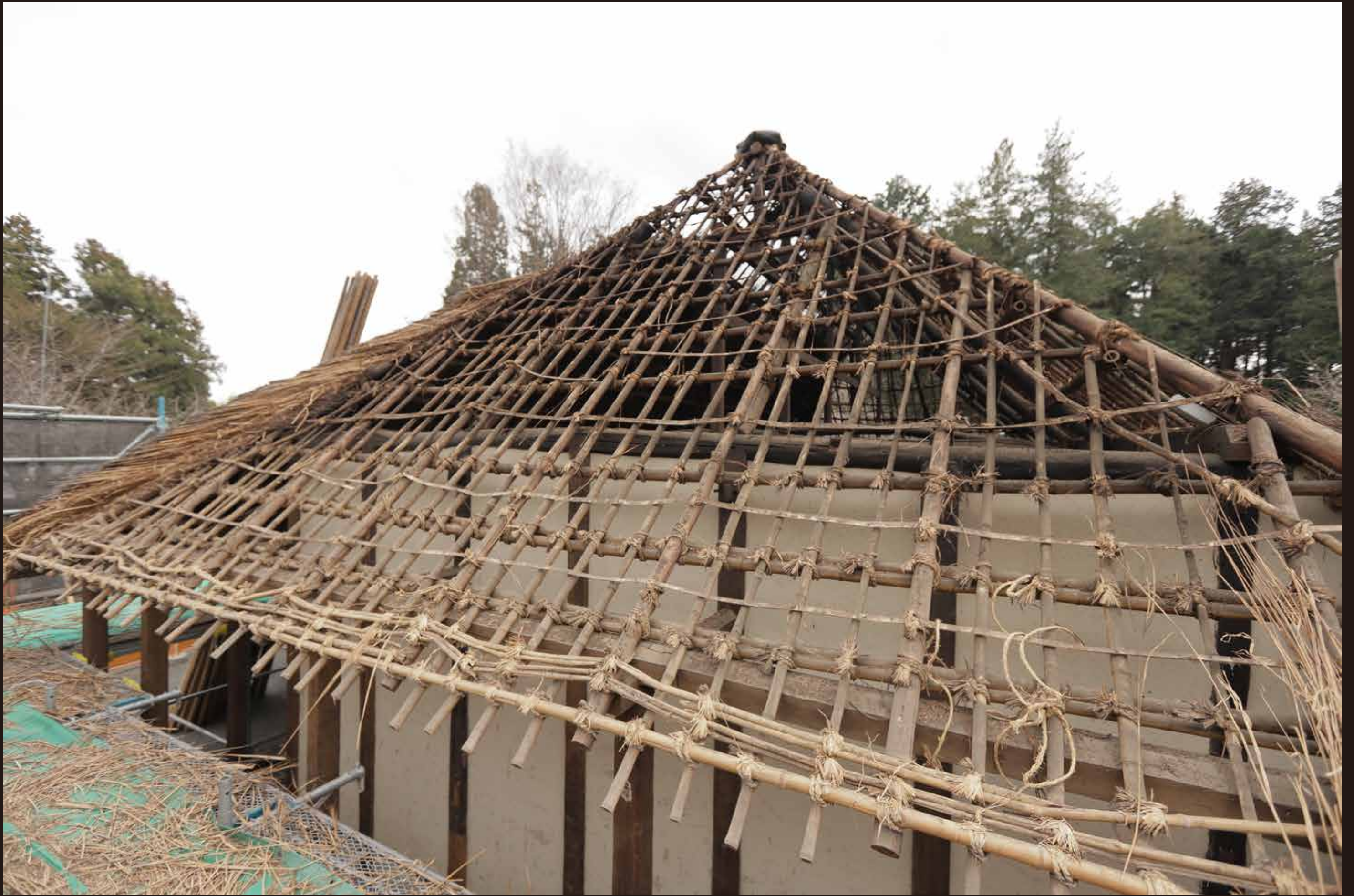
(古い茅をおろした後の屋根下地 | 茅零し | 2021年3月4日撮影)
