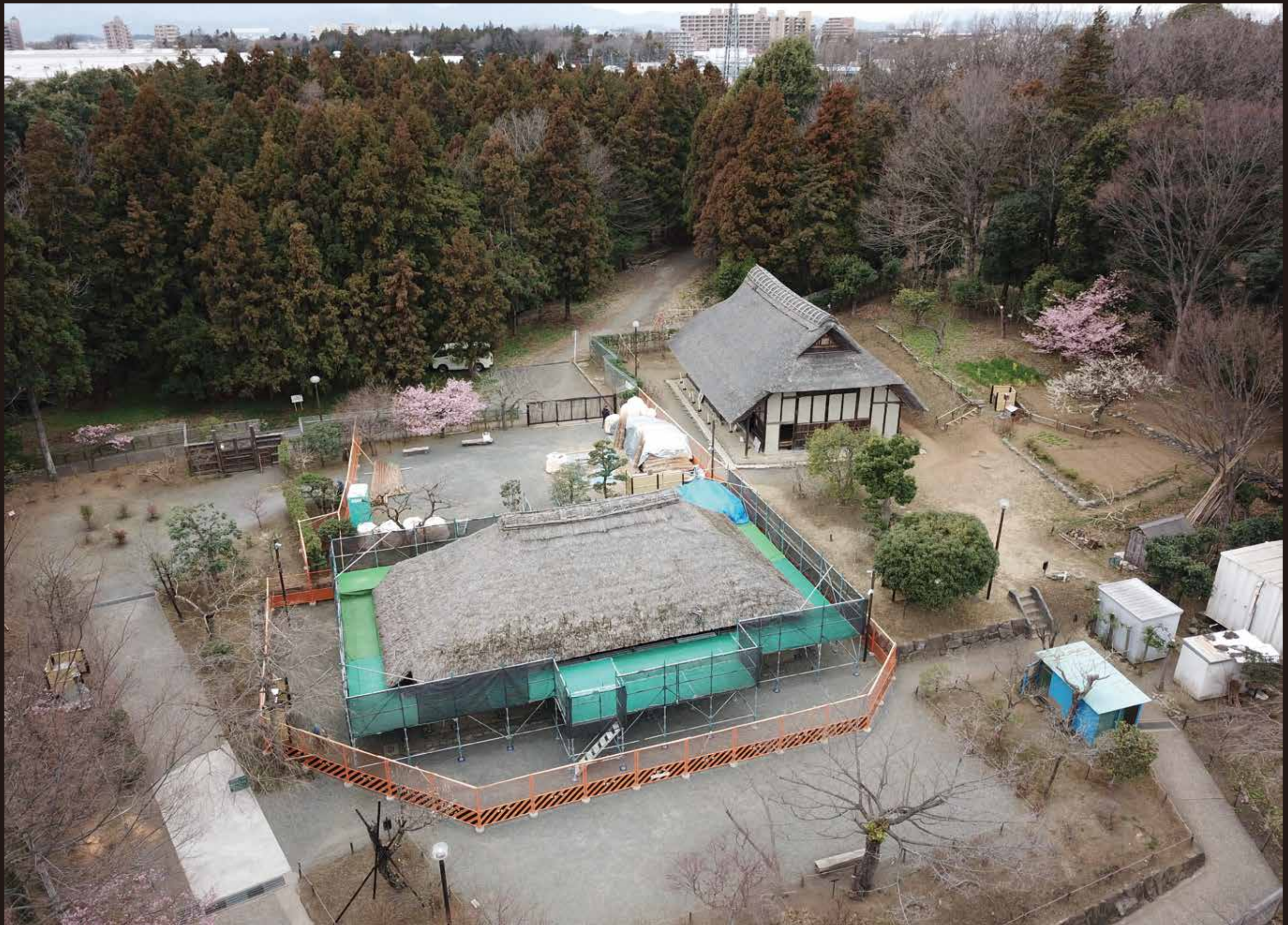
河津桜と梅の咲く頃、工事用に仮囲いがされ、茅が運び込まれました。 (葺き替え前 | 2021年2月26日ドローン撮影)
