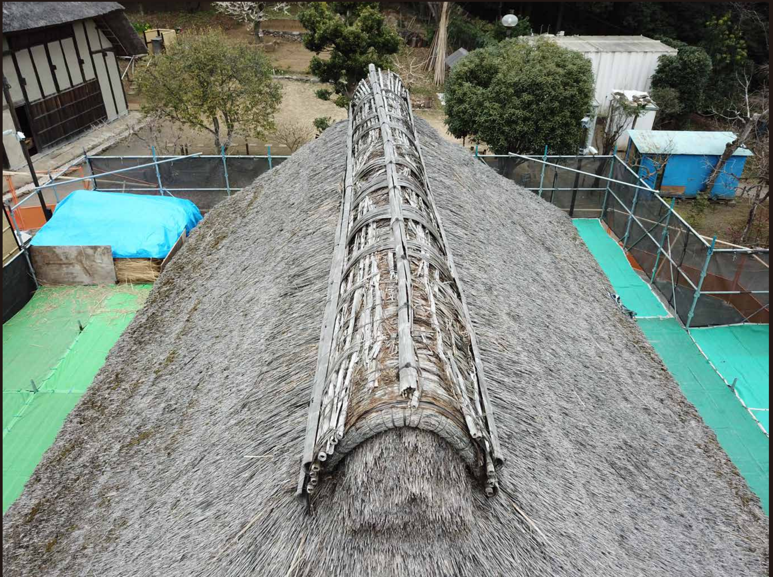
(葺き替え前 | 棟 | 2021年2月16日ドローン撮影)
