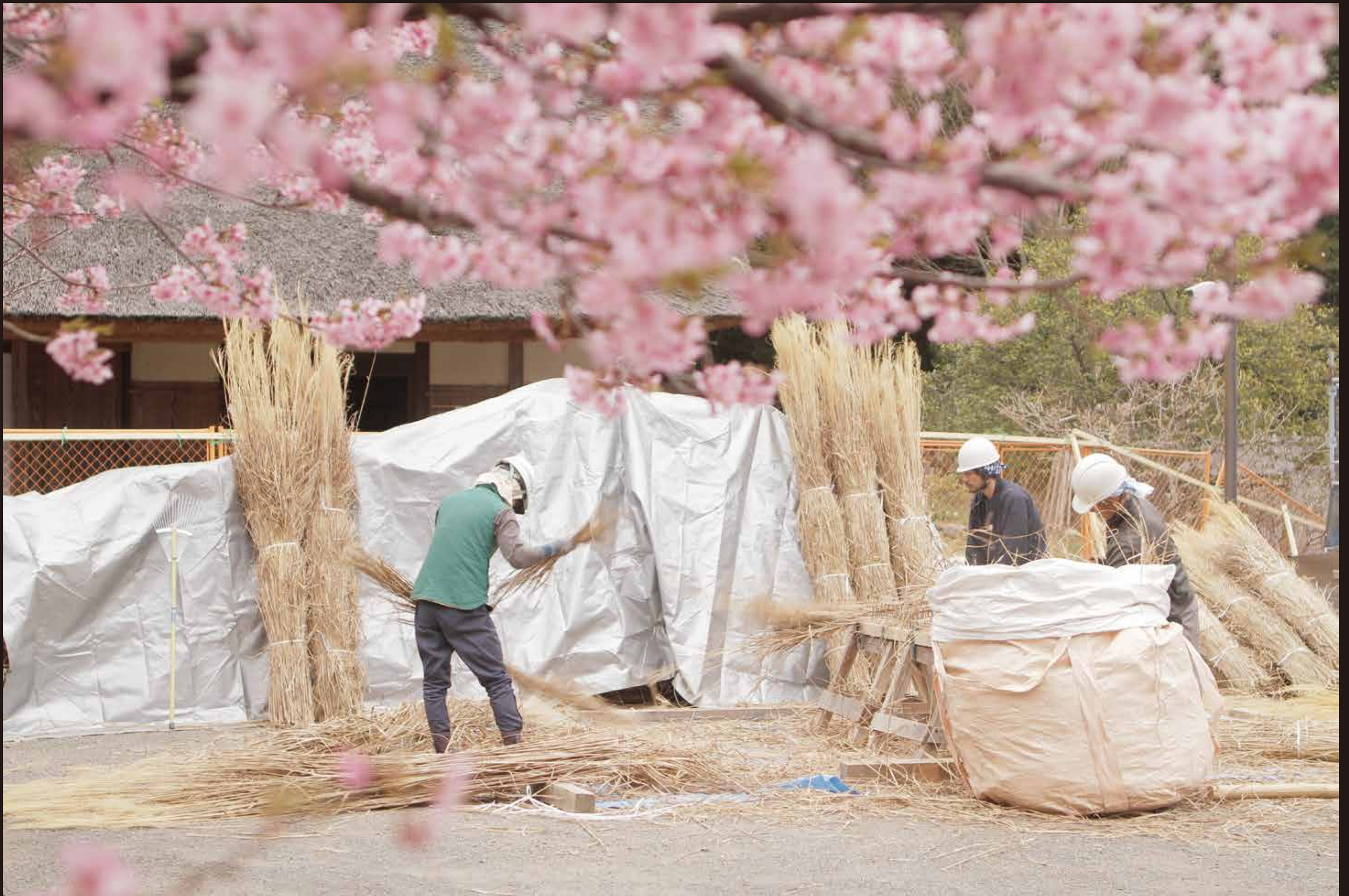
搬入された茅を葺くのに適した葉の量にする作業（茅すぐり）をし、屋根面を葺くための材料をこしらえています。屋根裏に見える一番下の化粧茅をまとめています。（2021年2月26日撮影）
