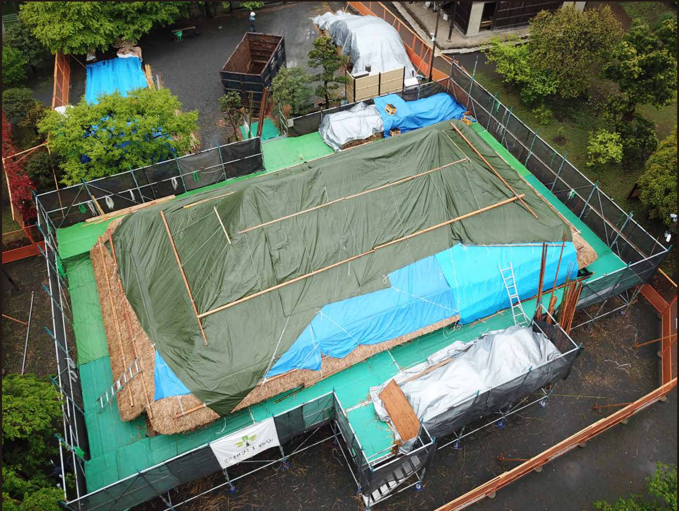
雨の日には、屋根面を葺いていないところはシートを掛けて養生をします (2021年4月14日撮影)
