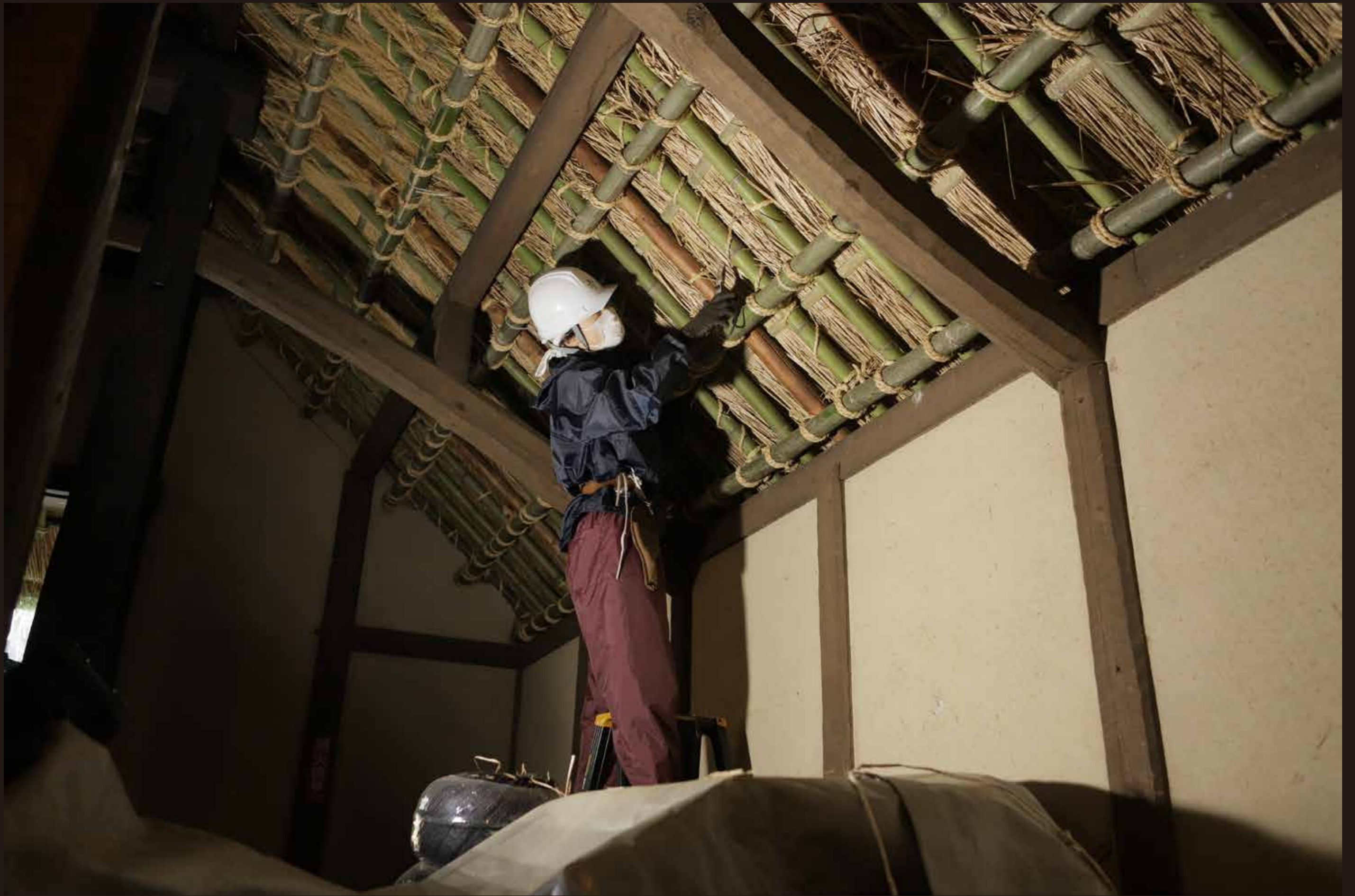
ケバ取りとよばれる作業で、屋根の内側に飛び出た茅をはさみで切り取り綺麗に整えます。(ケバ取り | 屋根の内側 | 2021年4月14日撮影)
