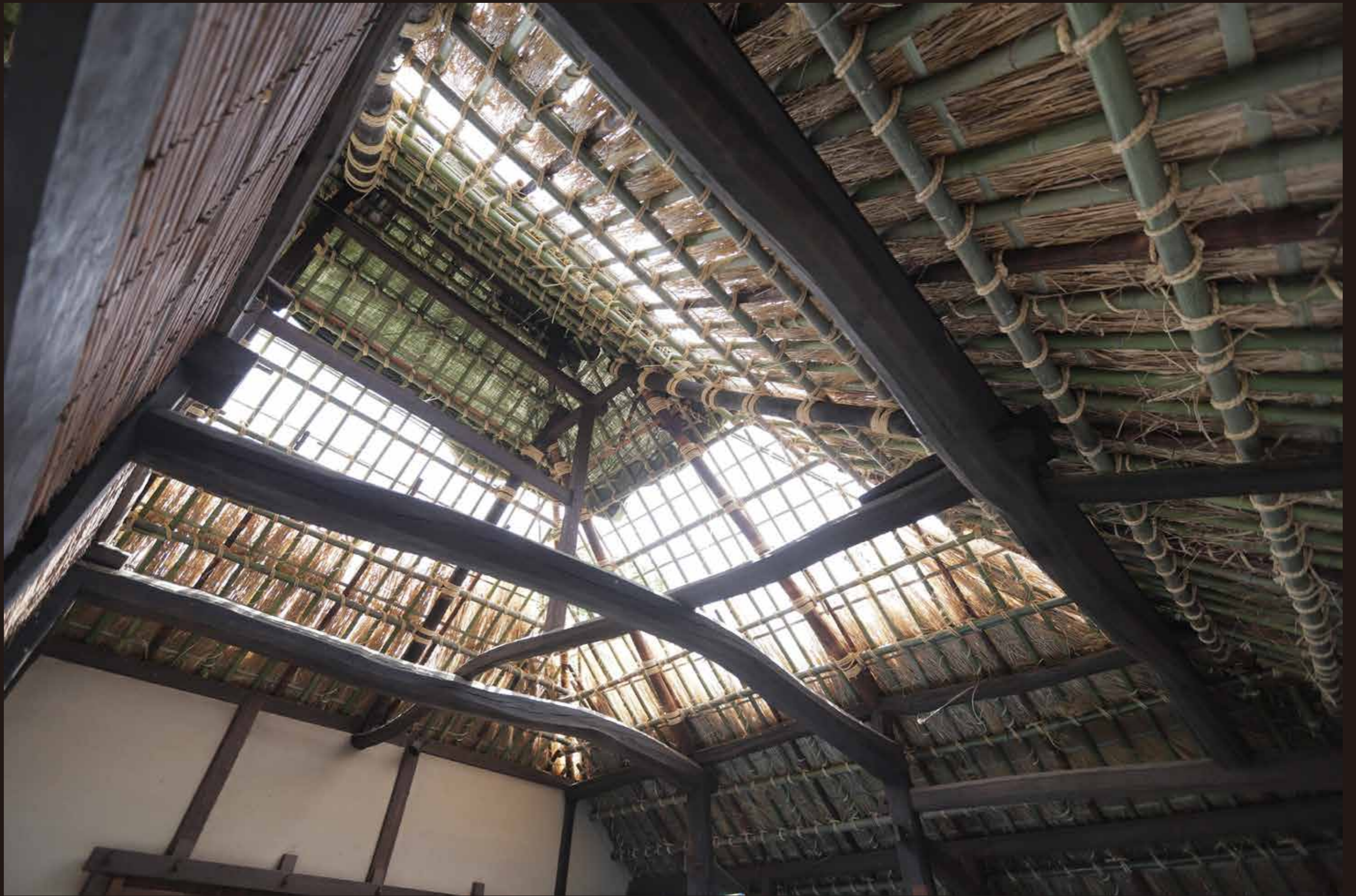
茅葺きが始まった屋根の内側は、近世からの燻された木材の色、若竹色と茅の黄金色のコントラストがみられます。（茅葺き | 屋根の内側 | 2021年4月8日撮影）
