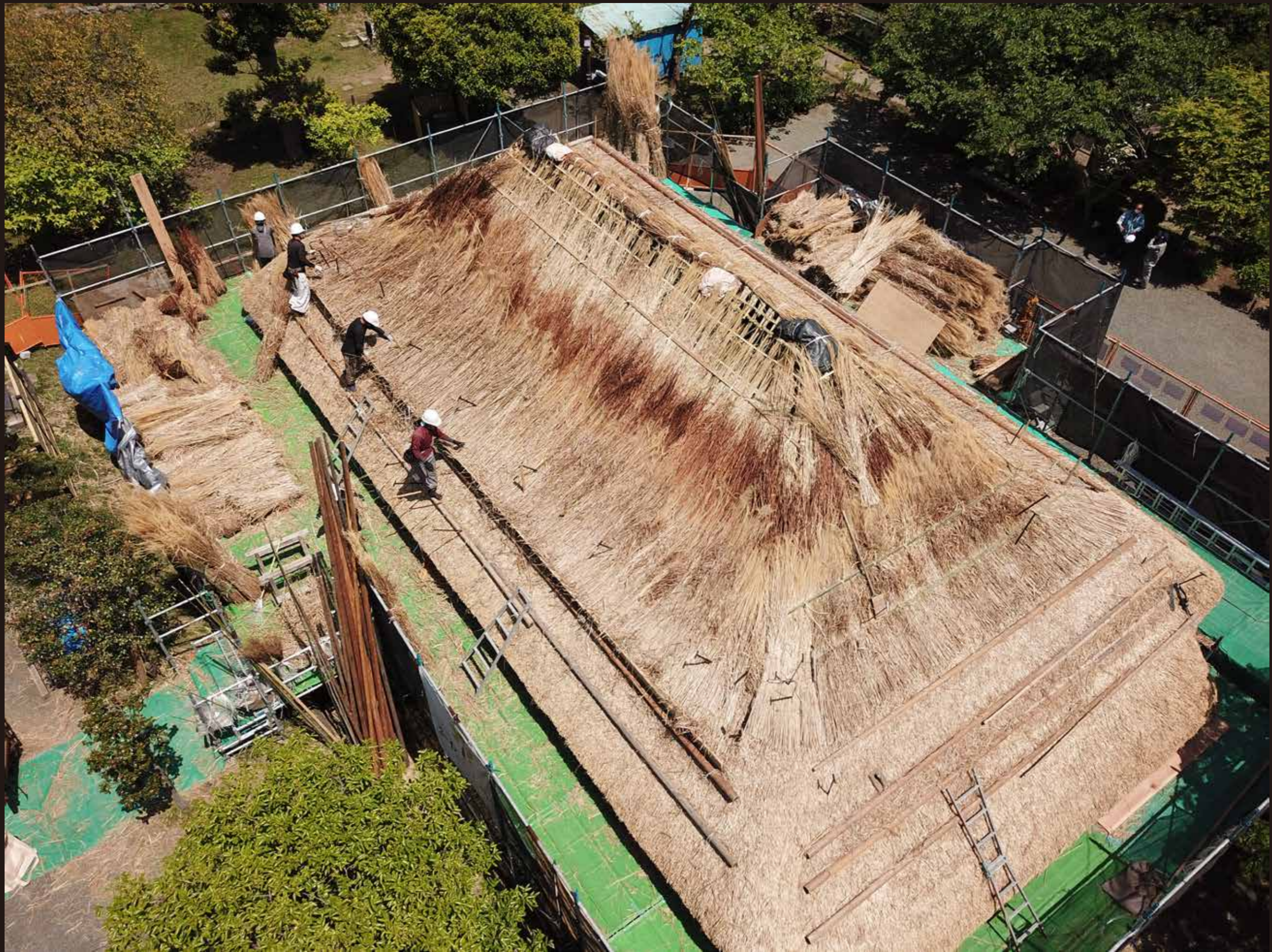
上に上がるほど屋根の面積は小さくなっていくので、葺き上がっていくスピードも上がります。(茅葺き | 屋根面を葺く | 2021年4月21日ドローン撮影)
