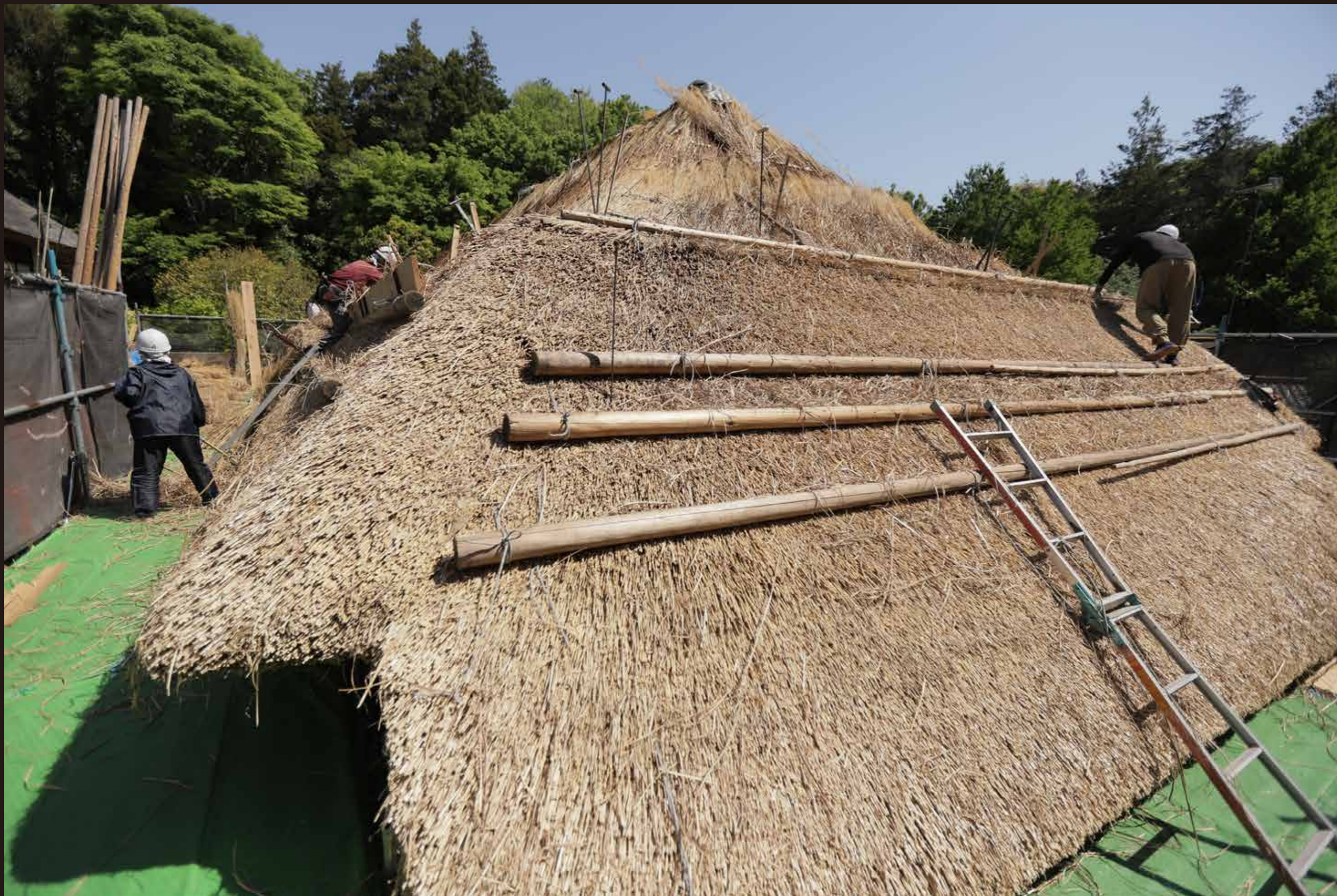
高さが上がるごとに足場の丸太も増えます。屋根面の半分程度が葺き上がってきました。(茅葺き | 屋根面を葺く | 2021年4月21日撮影)
