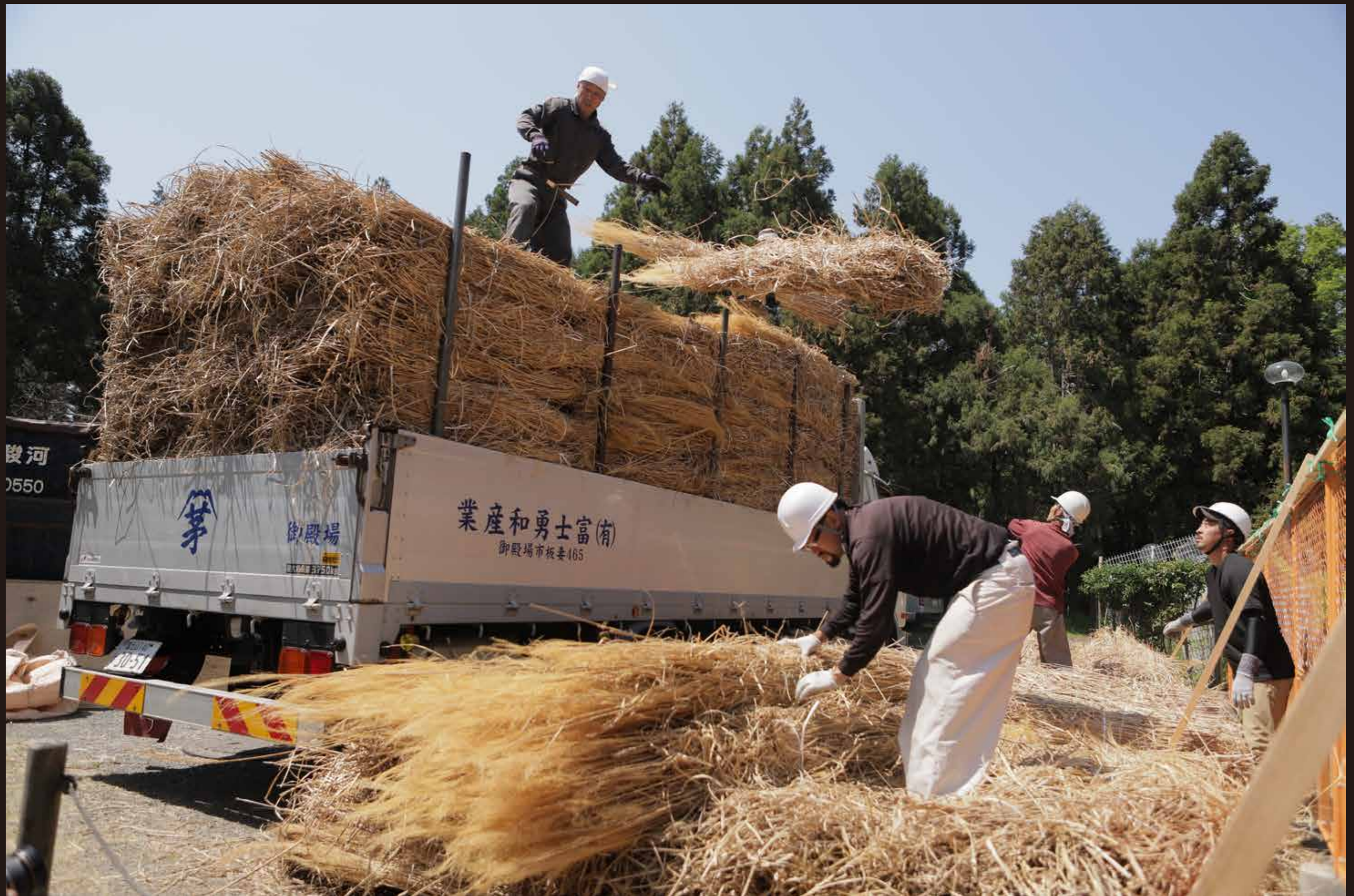
御殿場からトラックで追加の茅が搬入されます。この日で4回目の搬入で、葺き終わるまでには2,000束以上使われます。(茅の搬入 | 2021年4月21日撮影)
