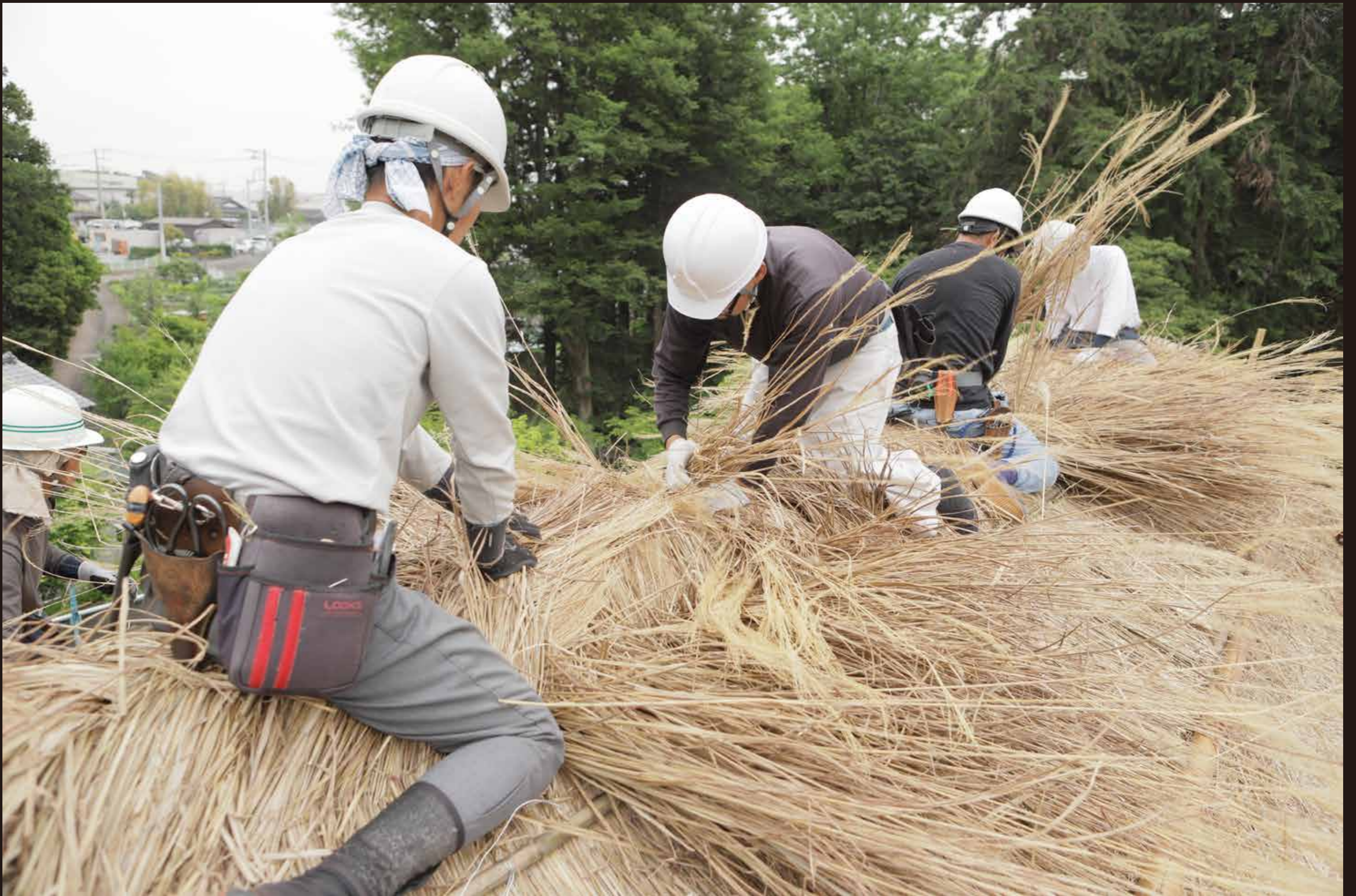
再び交互に編み込みます。「大まるき」とよばれる作業です。(棟づくり | 2021年5月7日撮影)
