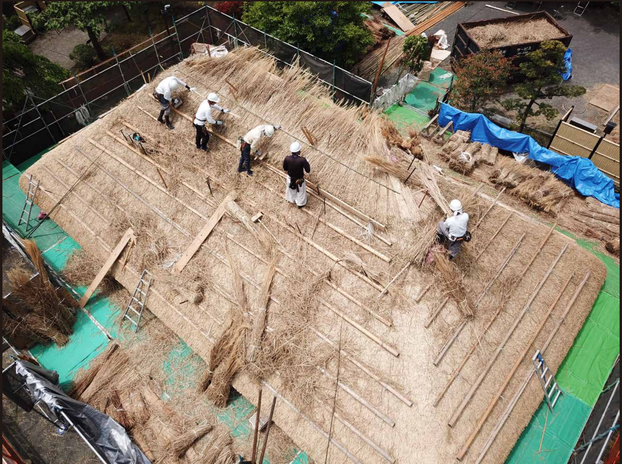
いよいよ上まで葺き上がります。(茅葺き | 屋根面を葺く | 2021年5月6日ドローン撮影)
