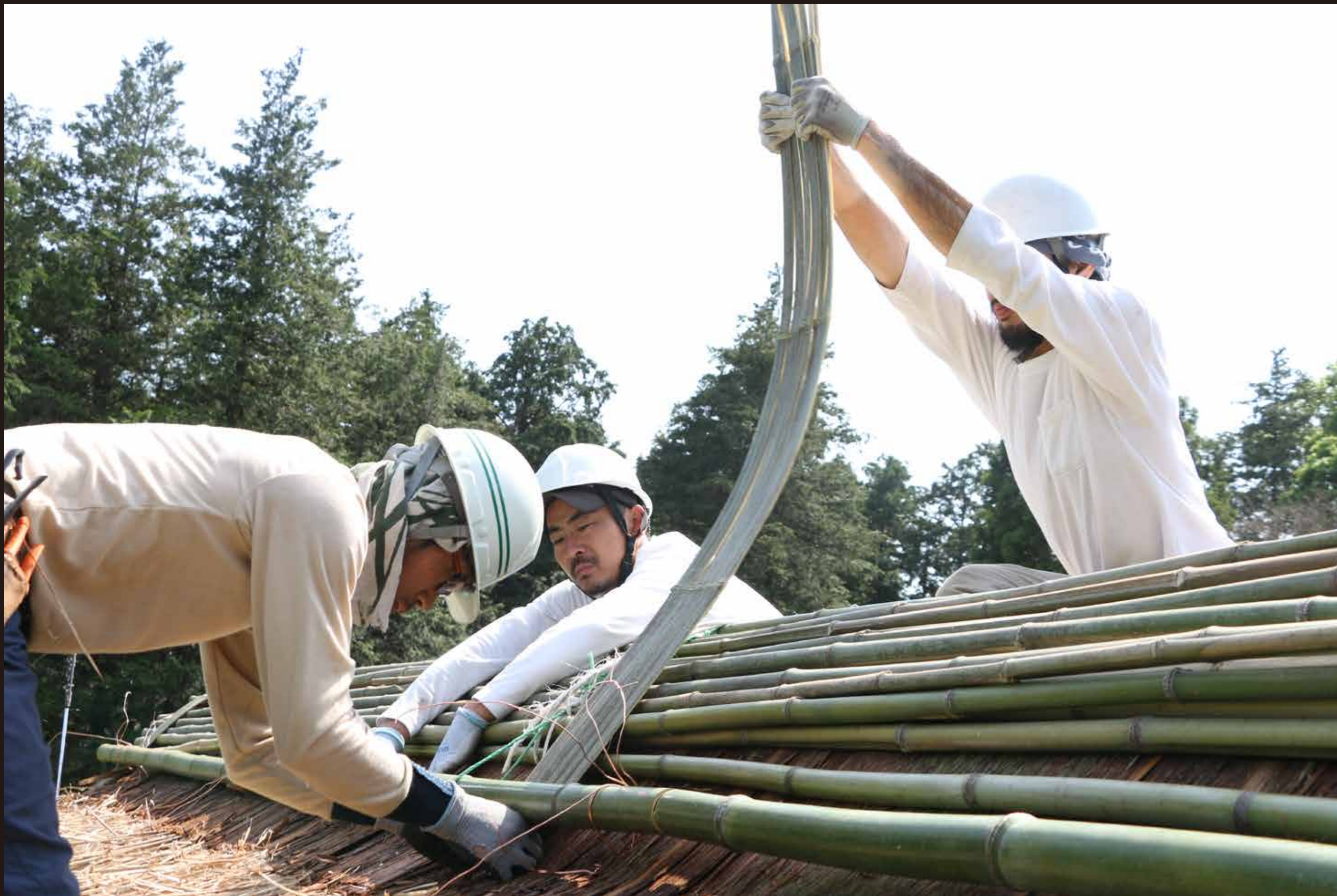
切り開いた竹で9か所押さえます。(棟づくり | 2021年5月10日撮影)
