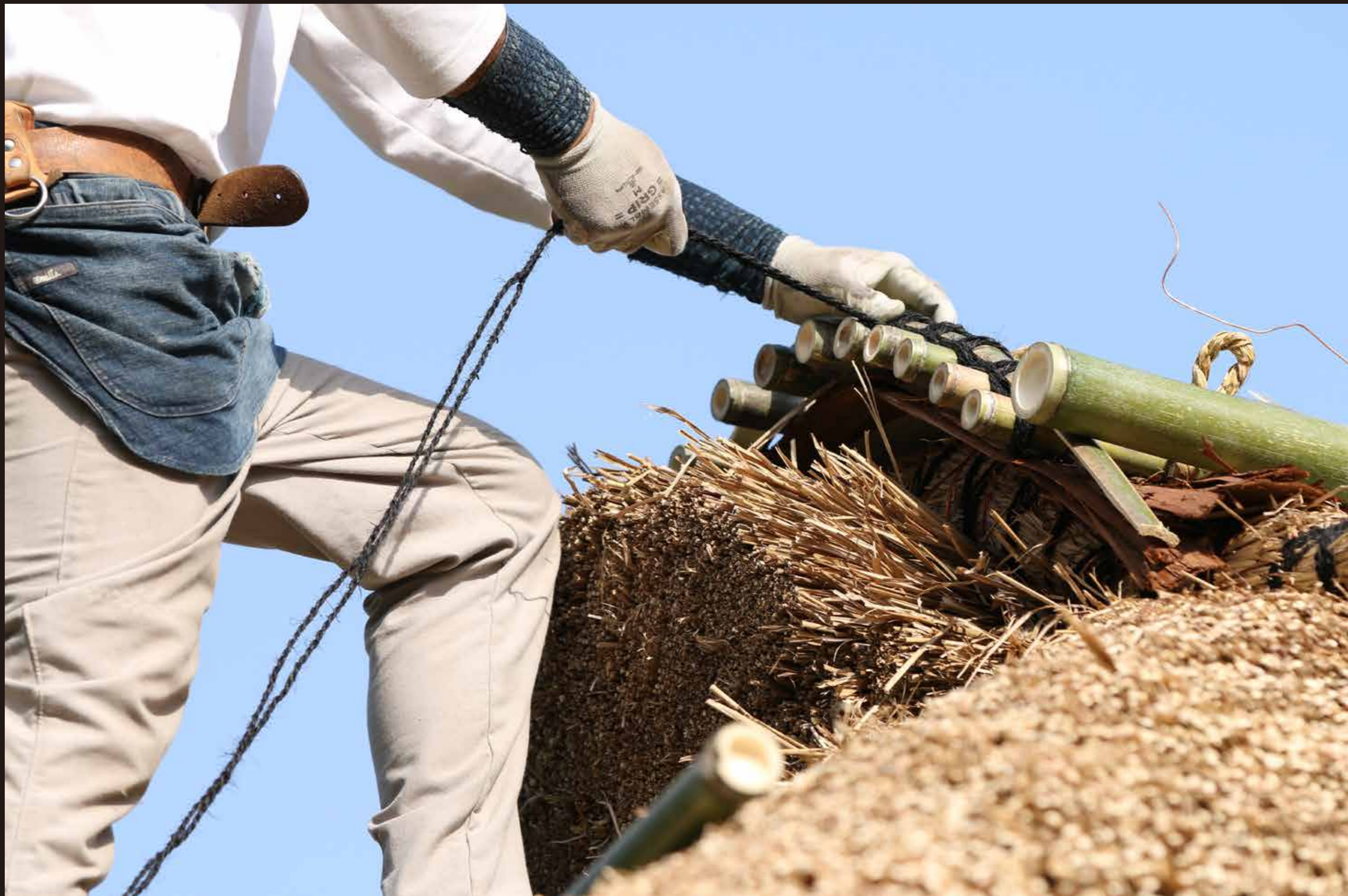
棟に載せた竹を細い縄で編み縛っていきます。写真で記録しきれないほど、棟づくりだけでたくさん の工程がありました。(棟づくり | 2021年5月10日撮影)
