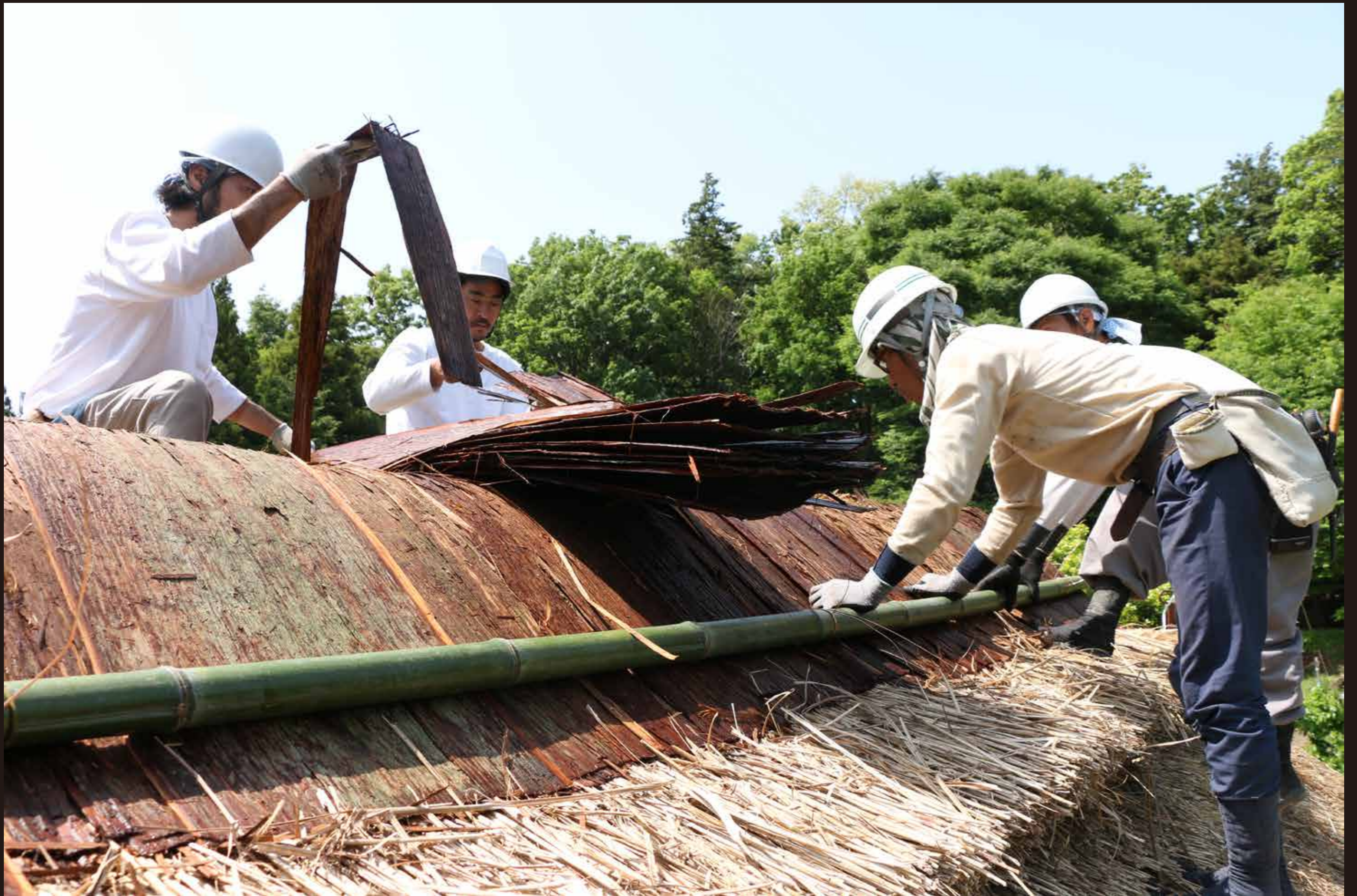
茅で編み上げた棟の上に、杉皮を載せ、竹で押さえます。(棟づくり | 2021年5月10日撮影)
