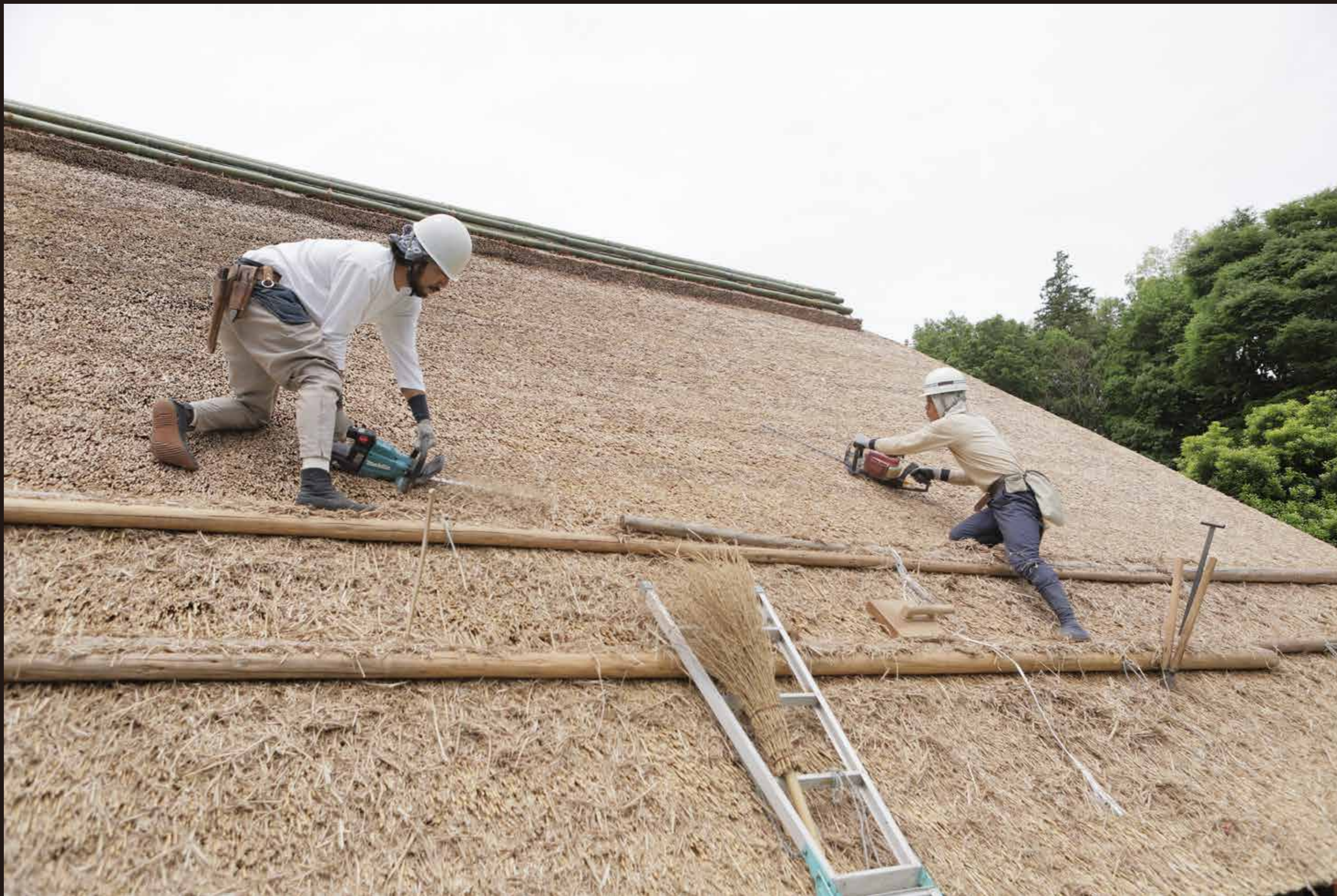
電動式刈り込み機も使用します。(刈り込み | 2021年5月12日撮影)
