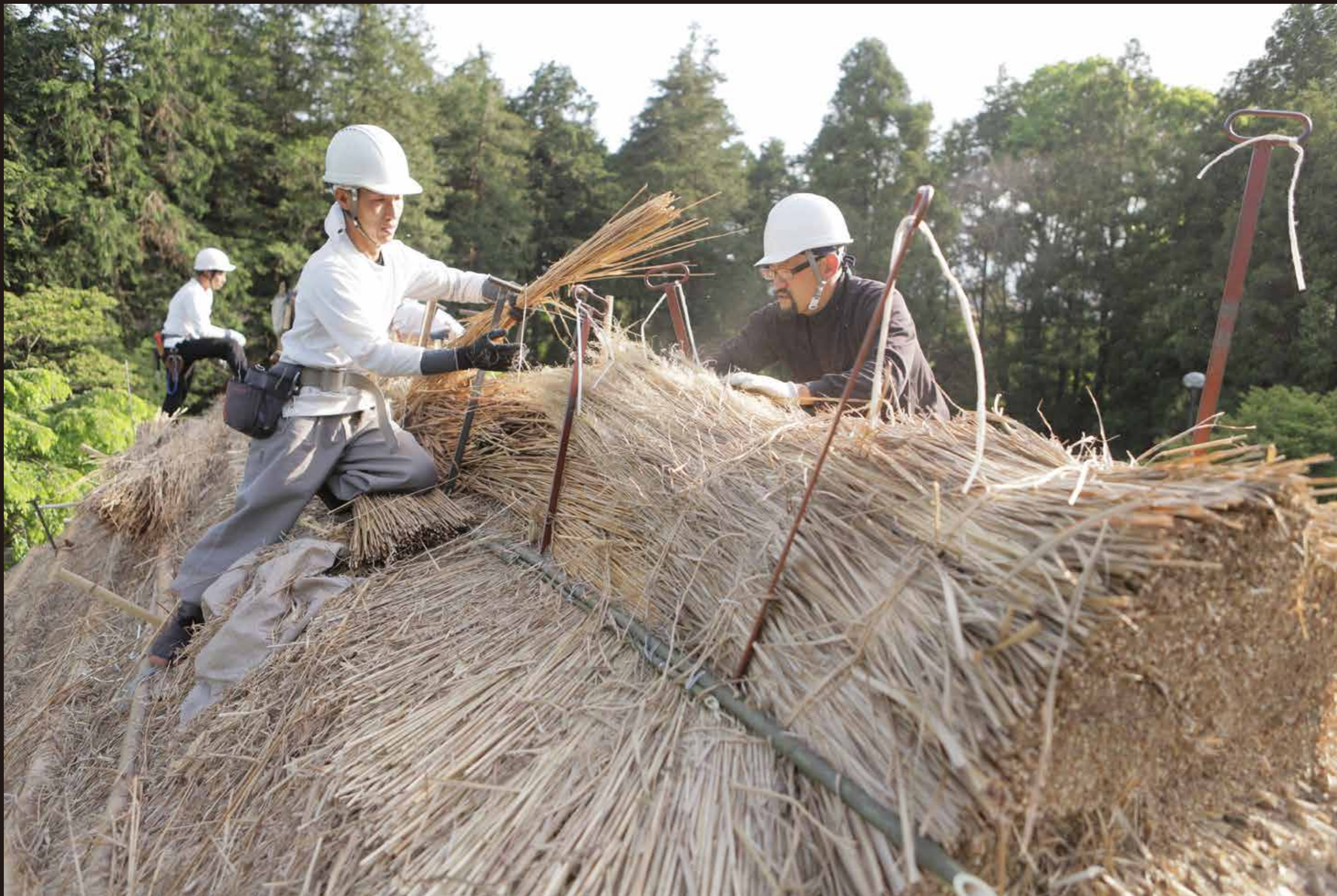
編み込んだ茅の上に、棟と平行の向きで茅をしき、縄で縛ります。(棟づくり | 2021年5月6日撮影)
