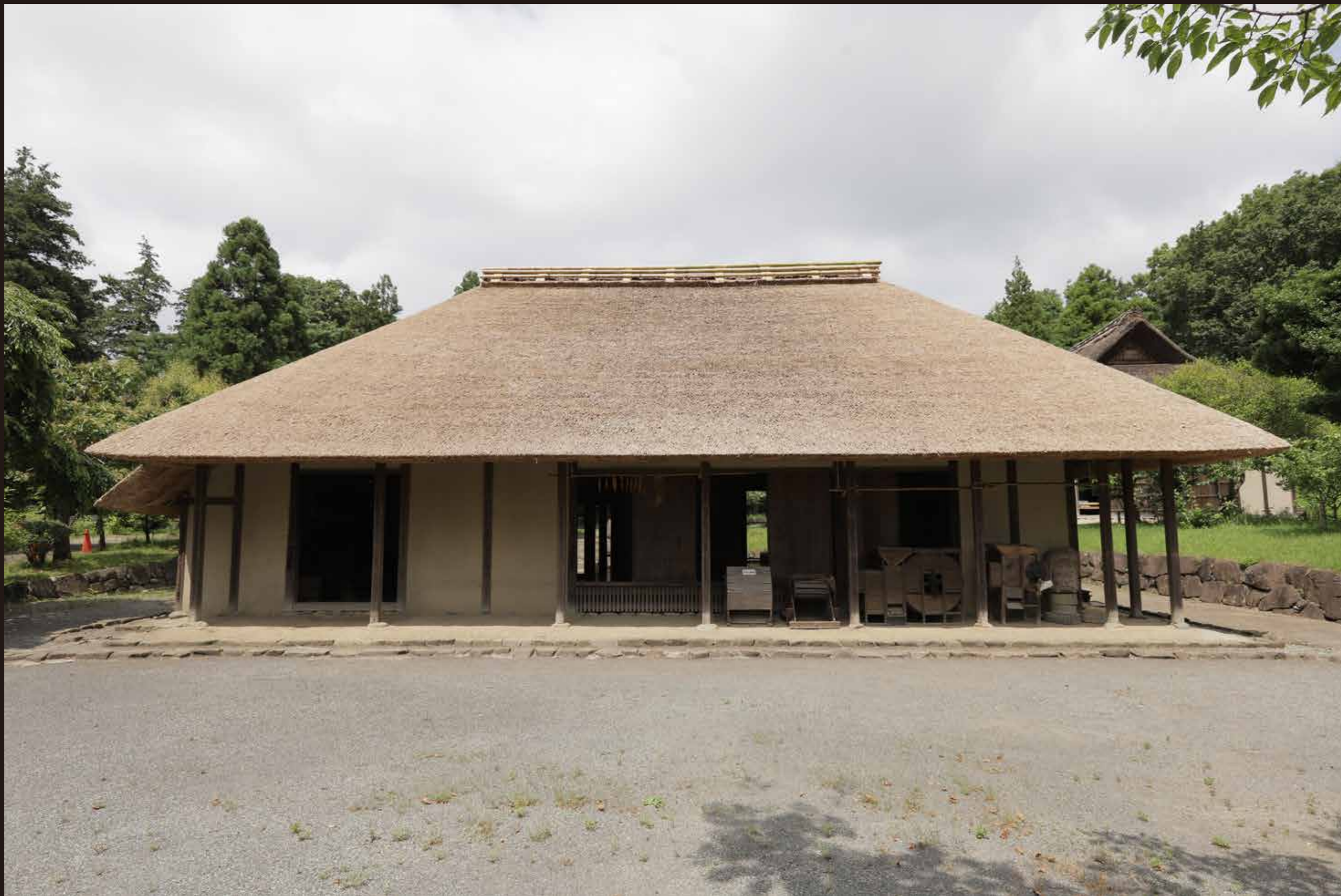
5月中旬、茅の葺き替えが完了しました。その後、土壁の補修や点検を終え、工事用囲いが取れ、お披露目となりました。(葺き替え完了 | 2021年7月20日撮影)
