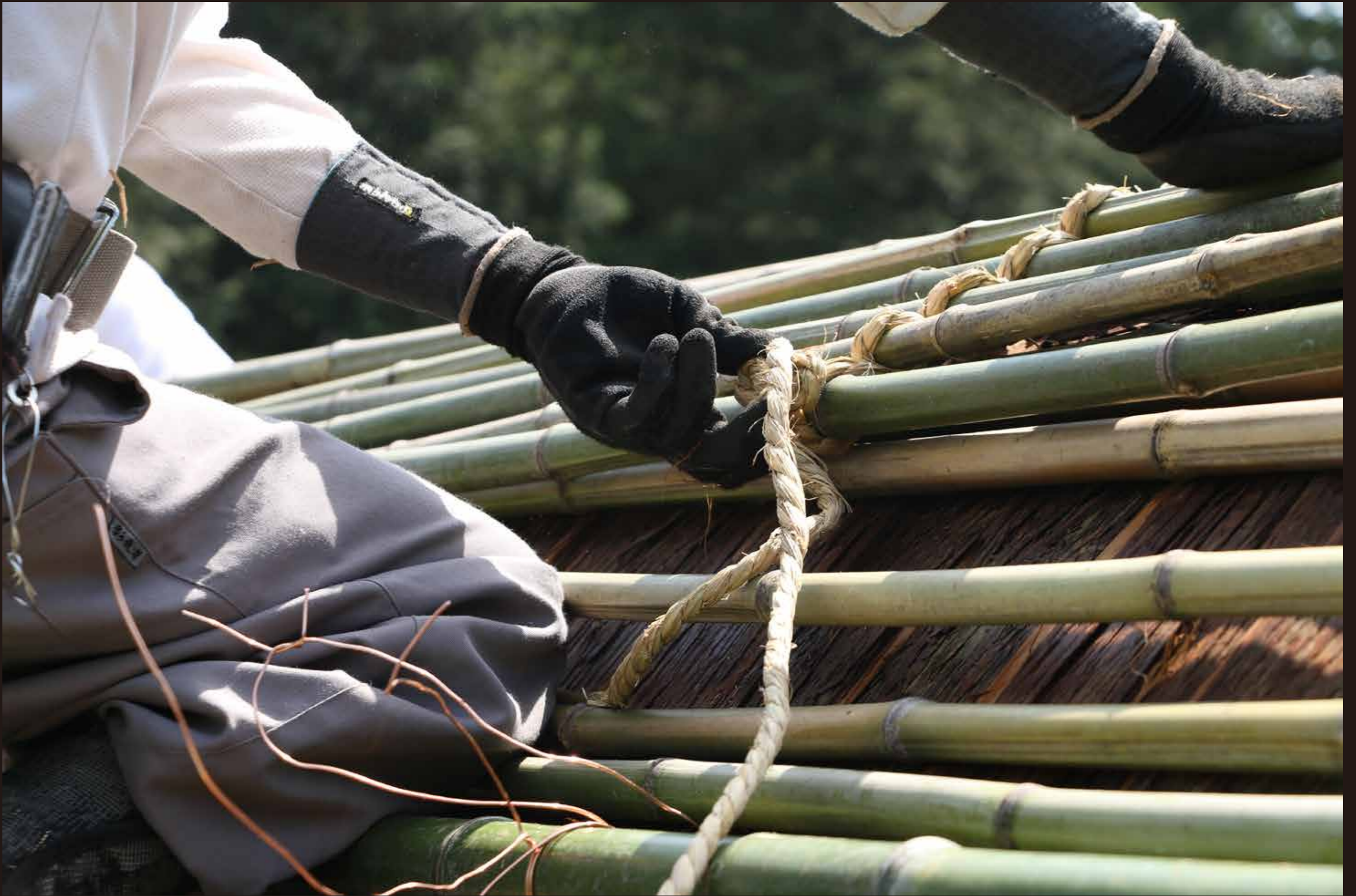
杉皮の上に竹を並べ、縄で編みつなげ、固定します。(棟づくり | 2021年5月10日撮影)
