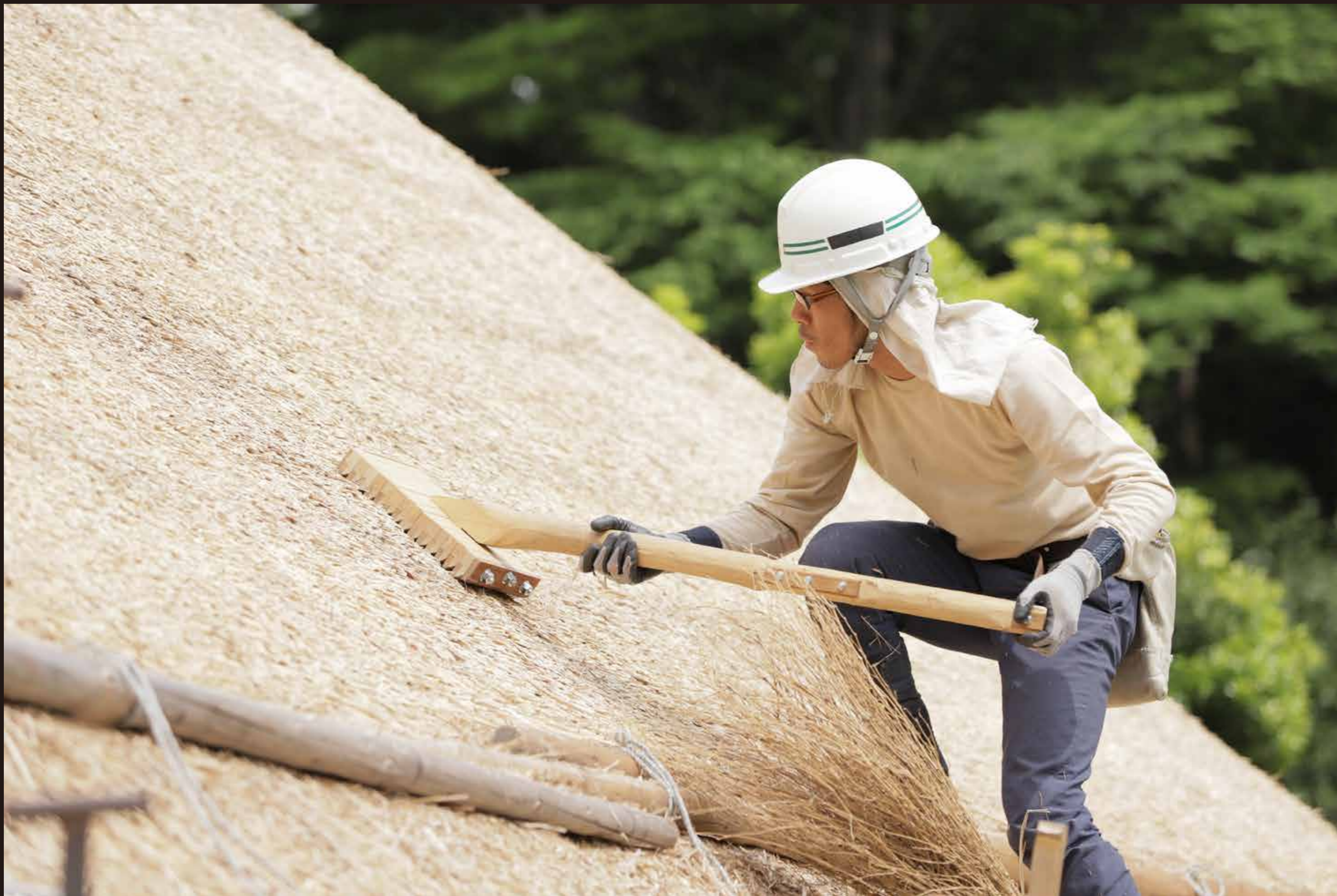
ガンギも使って整えます。(刈り込み | 2021年5月12日撮影)
