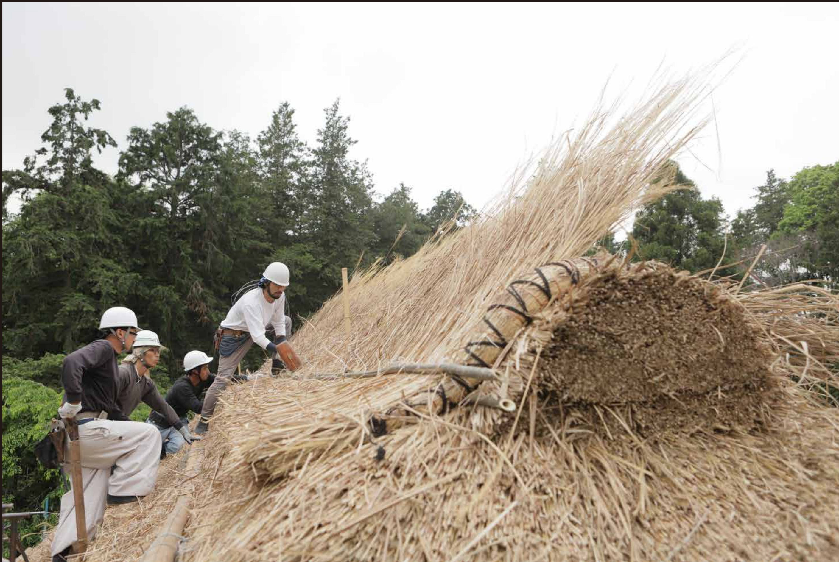
さらに棟に左右から茅を重ねます。(棟づくり | 2021年5月7日撮影)
