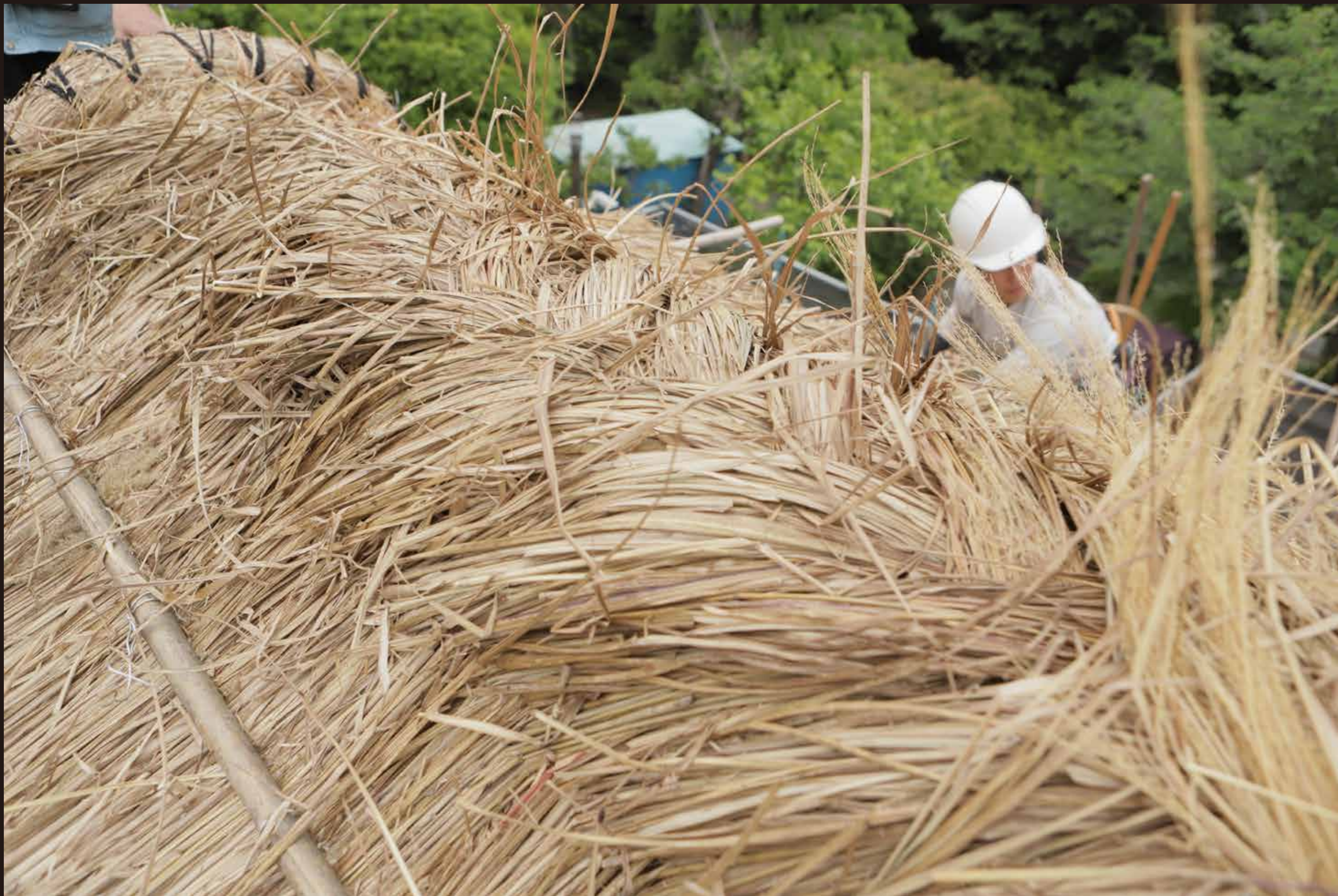
「大まるき」で編み込まれた棟部分の茅。(棟づくり | 2021年5月7日撮影)
