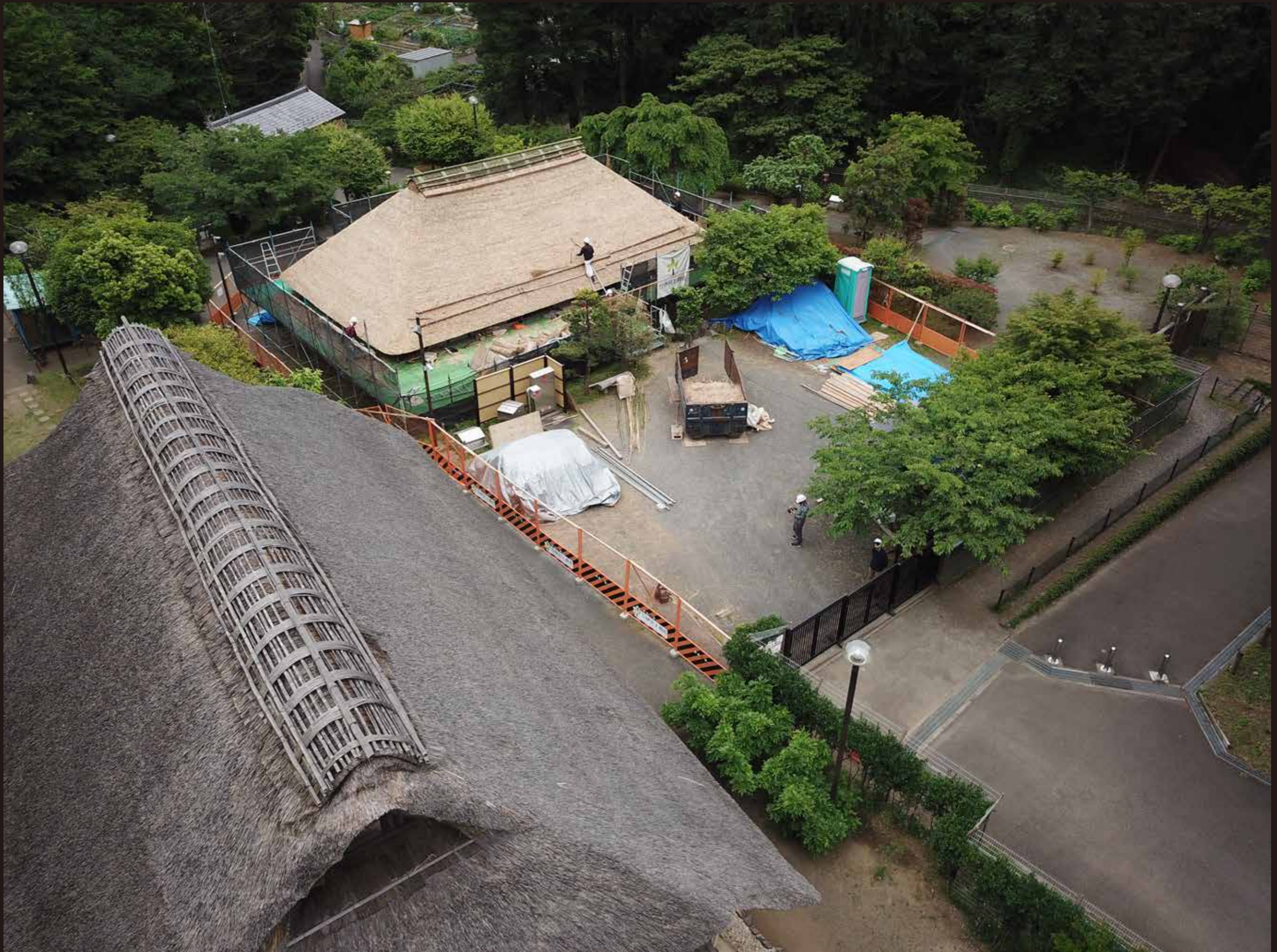
(刈り込み | 北島家の上から | 2021年5月12日ドローン撮影)
