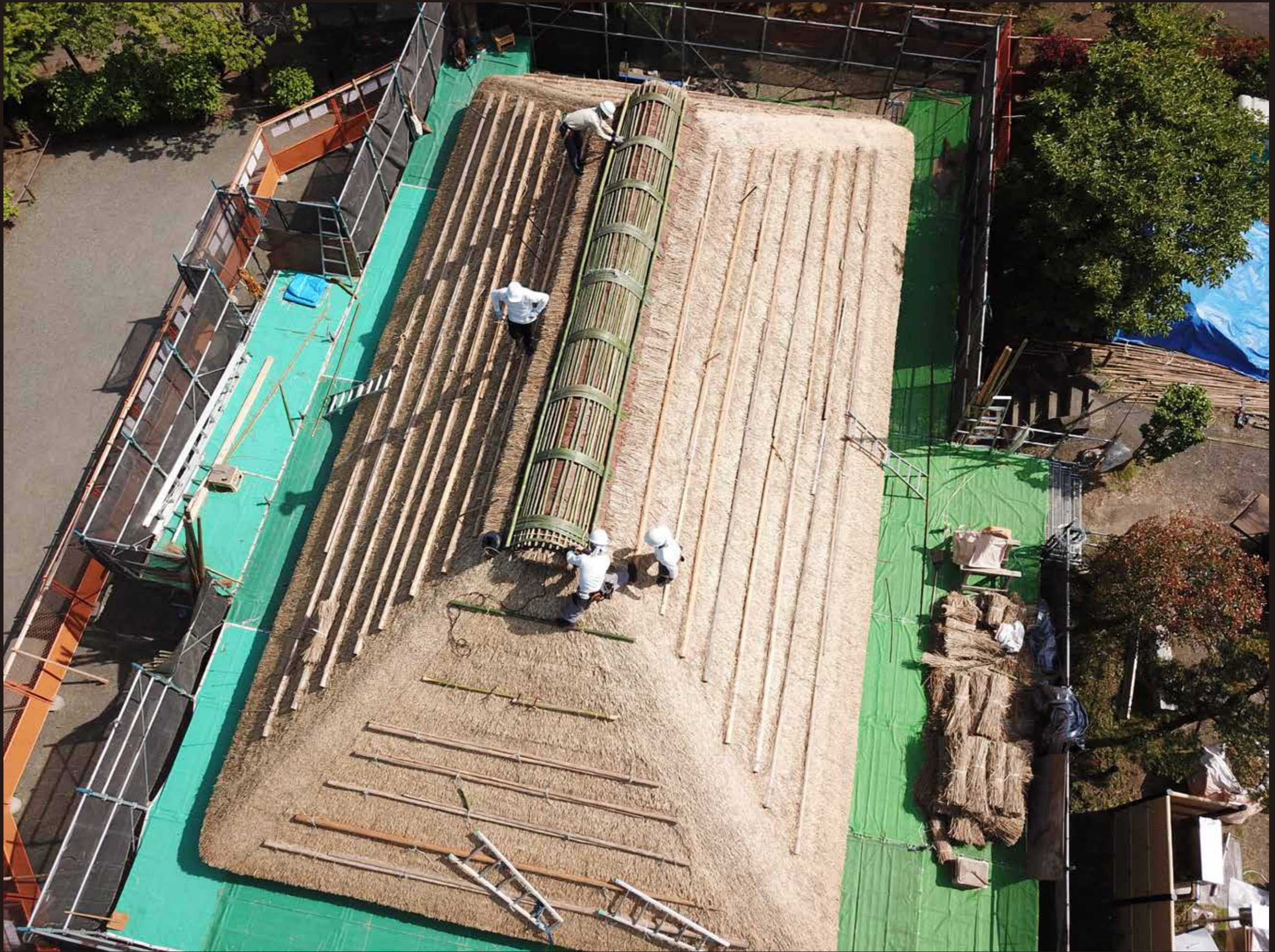
棟づくりが終わり、最後の仕上げ、刈り込みに移ります。(2021年5月10日ドローン撮影)
