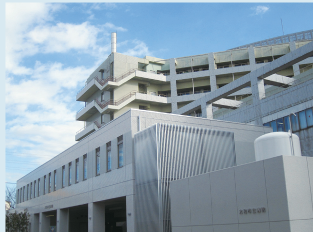
病院敷地内北側に位置する2階建ての救急棟
