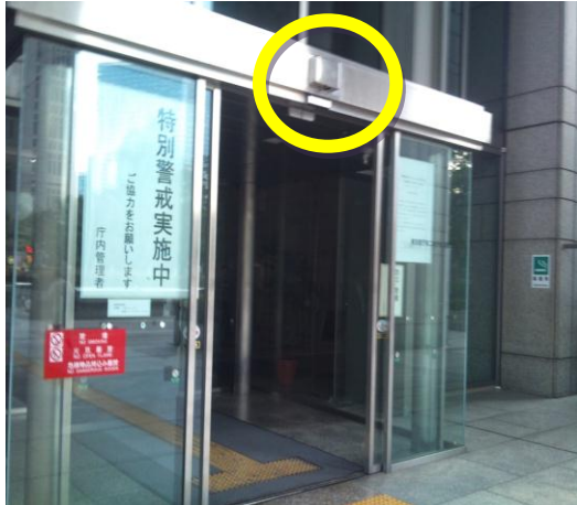
建物の入口を音で知らせる自動ドア。視覚に障がいがある人でも分かりやすくなっている
