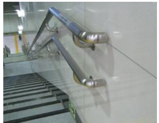
下段の手すりは握りやすいように、直径が小さくなっている
