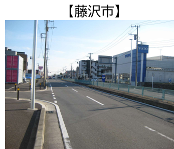
福田相模原線(福田地区)の 接続先道路 (石川下土棚線) 上谷台山王添線の南側
