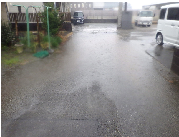
生活道路の冠水 2
