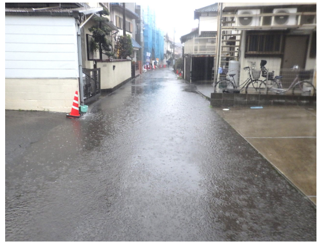
生活道路の冠水 1
