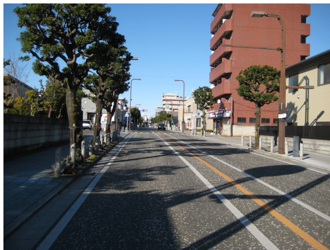
無電柱化された緊急輸送道路(県道40号)
