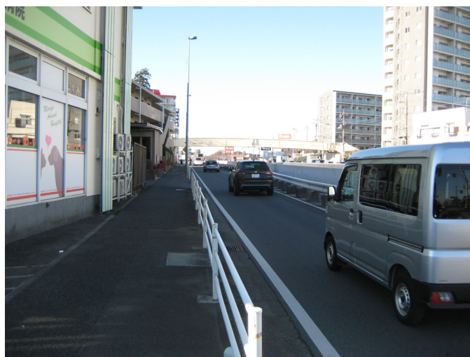
無電柱化された緊急輸送道路(国道16号側道)
