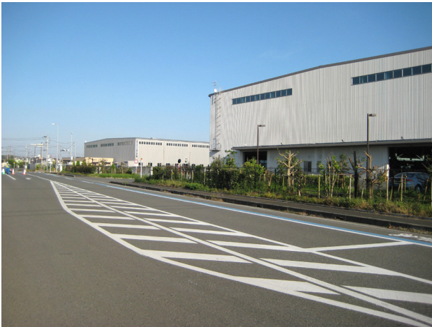
物流施設(藤沢市)
