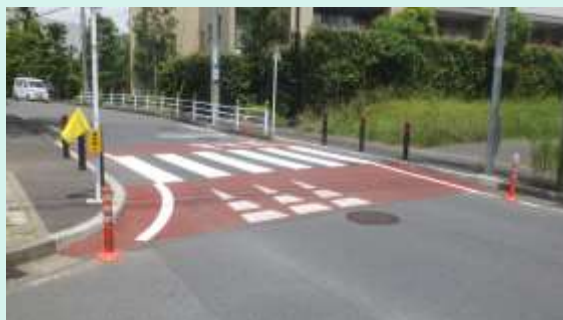
スムーズ横断歩道の設置例（横浜市緑区）
