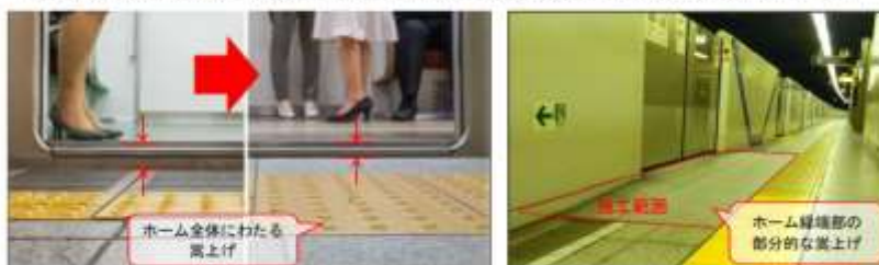
東京地下鉄丸ノ内線の例
