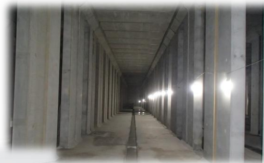
南林間調整池
