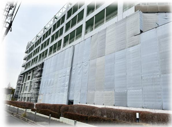
市立病院の外壁改修工事
