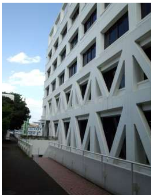
大和市役所本庁舎の耐震補強の状況
