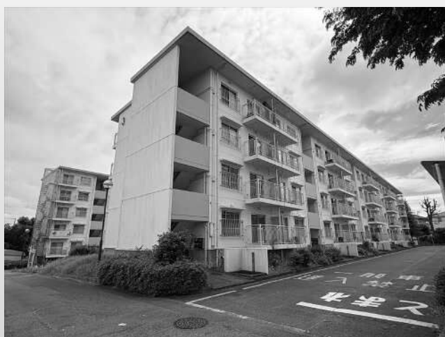
現地写真(3号棟)
