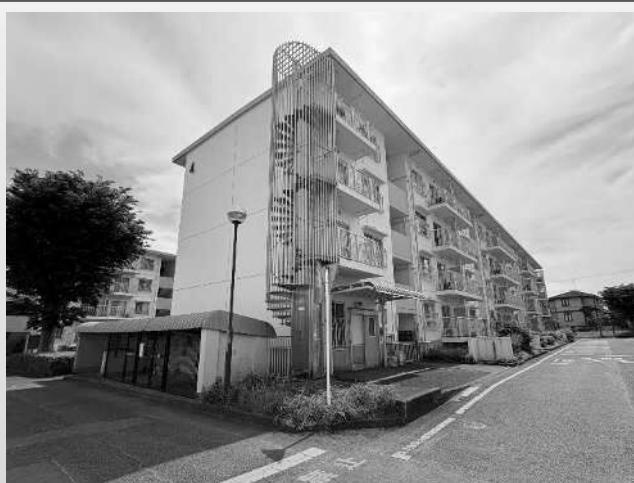
現地写真(4号棟)
