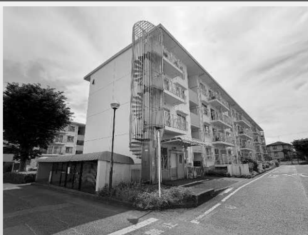
現地写真(4号棟)
