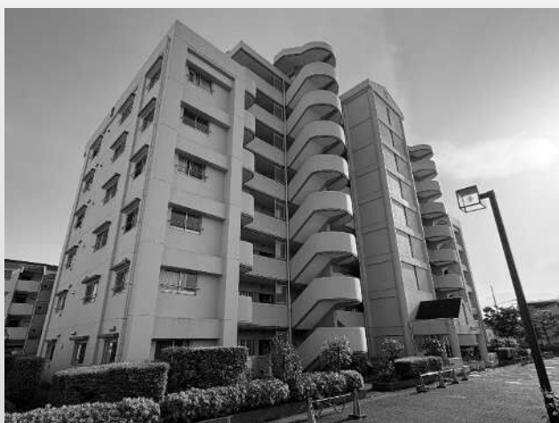
現地写真(2号棟)
