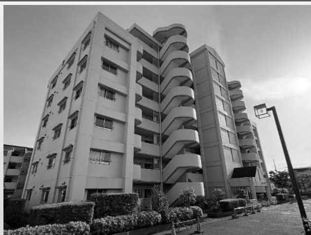
現地写真(2号棟)
