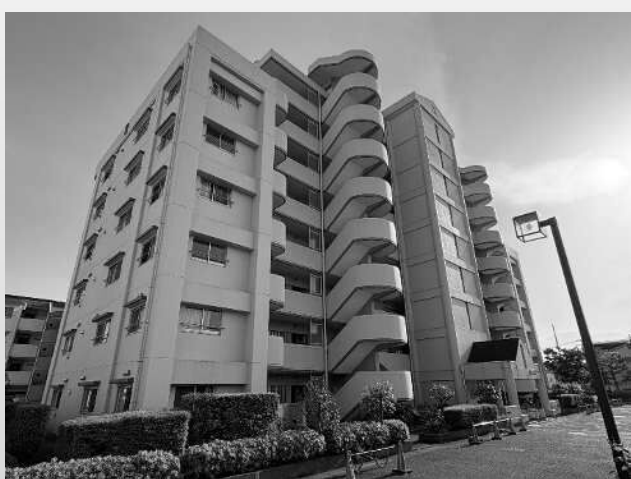
現地写真(2号棟)
