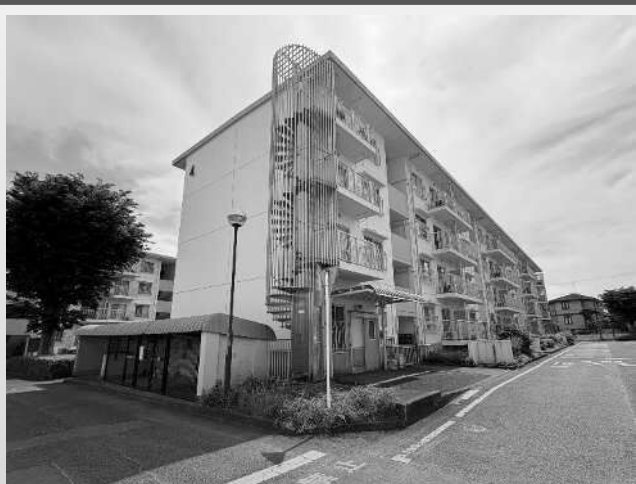
現地写真(4号棟)
