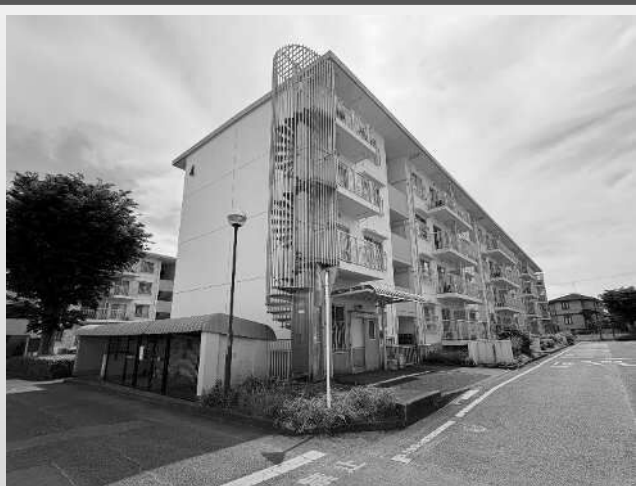
現地写真(4号棟)
