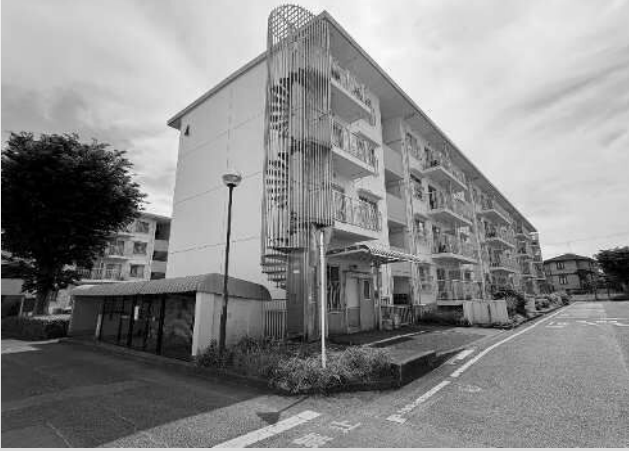
現地写真(4号棟)
