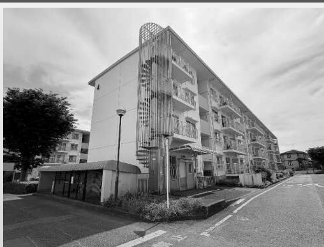
現地写真(4号棟)
