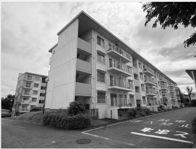
現地写真(3号棟)
