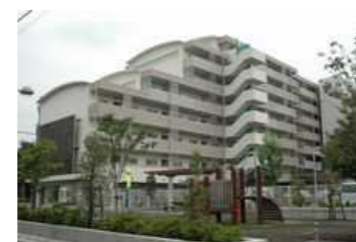
市営鶴間台住宅
