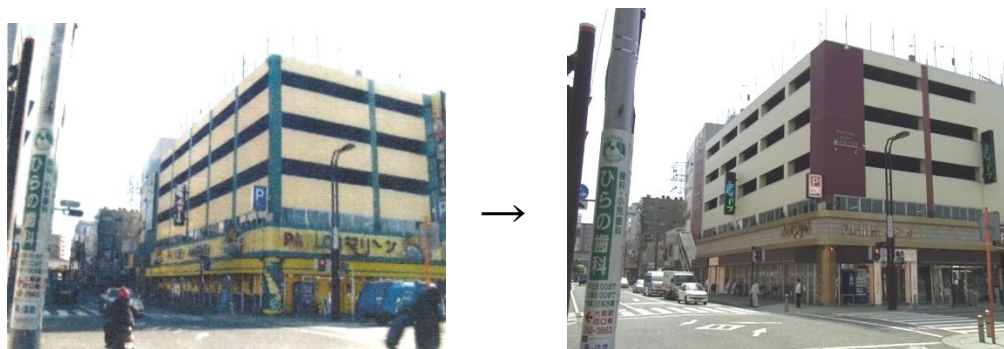
改修時に屋外広告物条例と景観計画・景観条例に基づき指導を行った例
