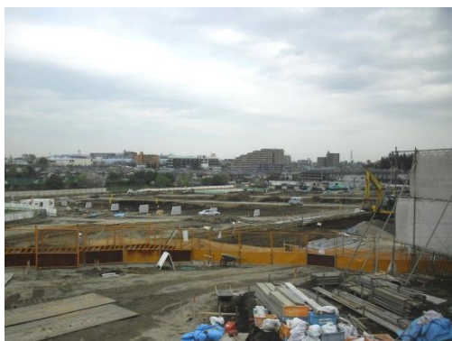
施行状況写真(施行全景)
