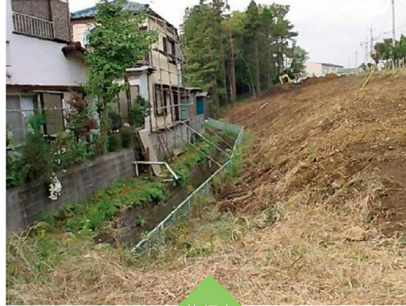
施行地区南端(小田急線西側)
