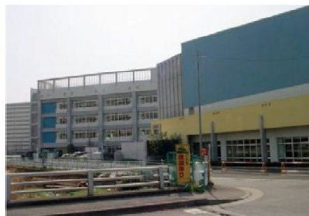
新設された新渋谷中学校(下和田小学校跡地)
