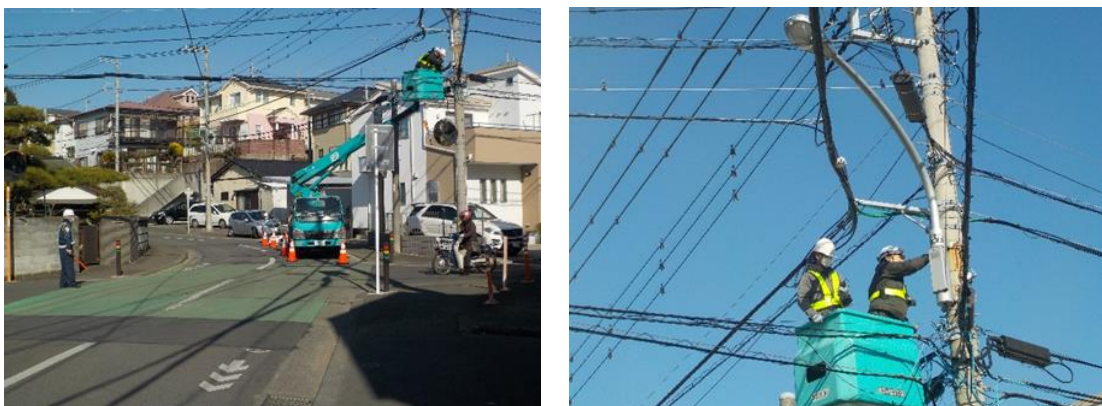
写真3-1 道路附属物の点検状況
