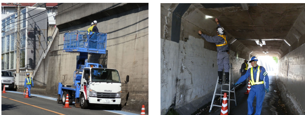
写真5-1 道路構造物の点検状況
