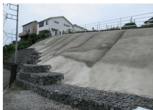
写真2-3 斜面安定工の例
