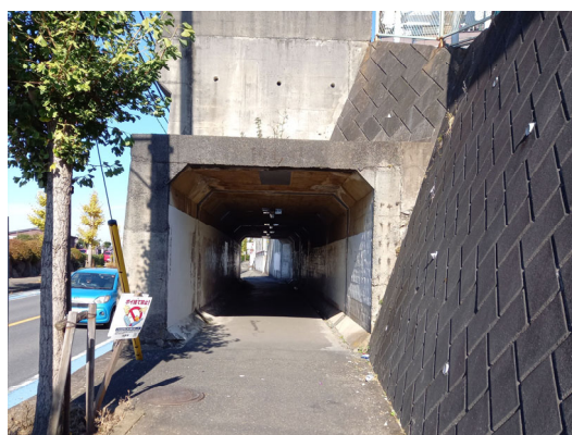
写真2-2 ボックスカルバートの例
