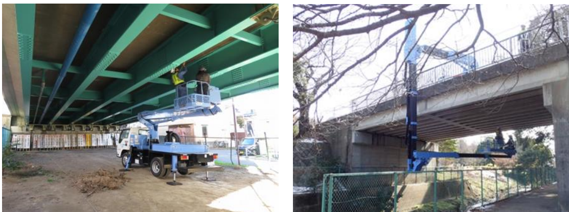
写真 6-1 橋りょう点検状況
