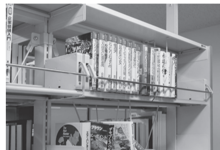
作動している書籍落下防止装置
